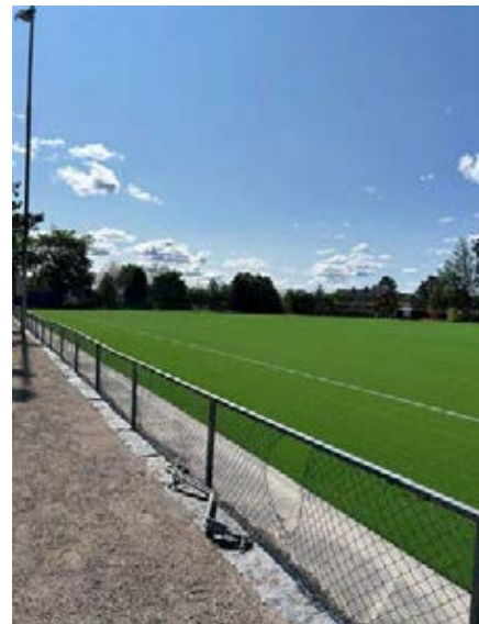
Prosjekt: Korsvoll 1 og 2 Entreprenør: JR Anlegg AS
