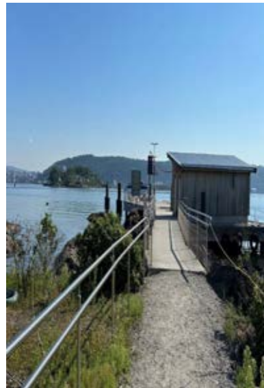
Prosjekt: Gressholmen avdriftspeler Entreprenør: Dykkerteknikk AS
