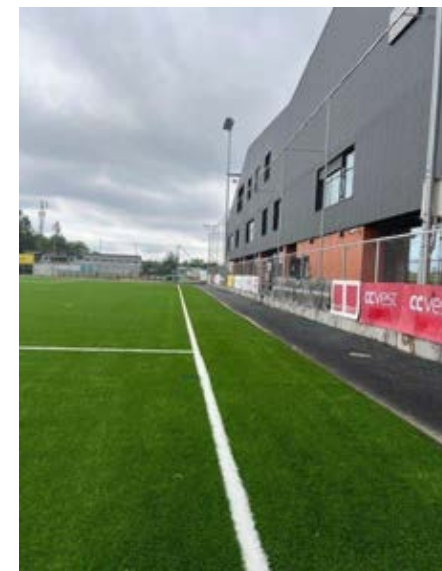
Prosjekt: Ullern 1 Entreprenør: JR Anlegg AS
