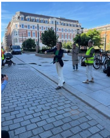
Prosjekt: Akersgata Entreprenør: Agaia AS
