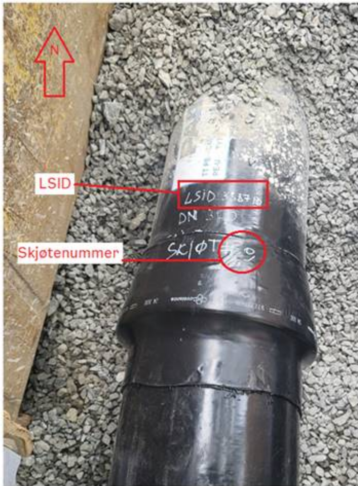
Figur 11: Rør med montert krympemuffe.
