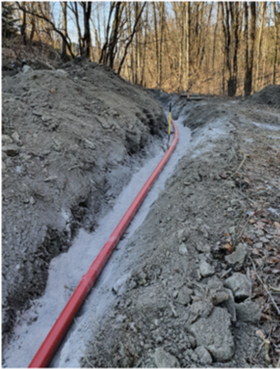
Figur 13a: Grøft med el-anlegg.
