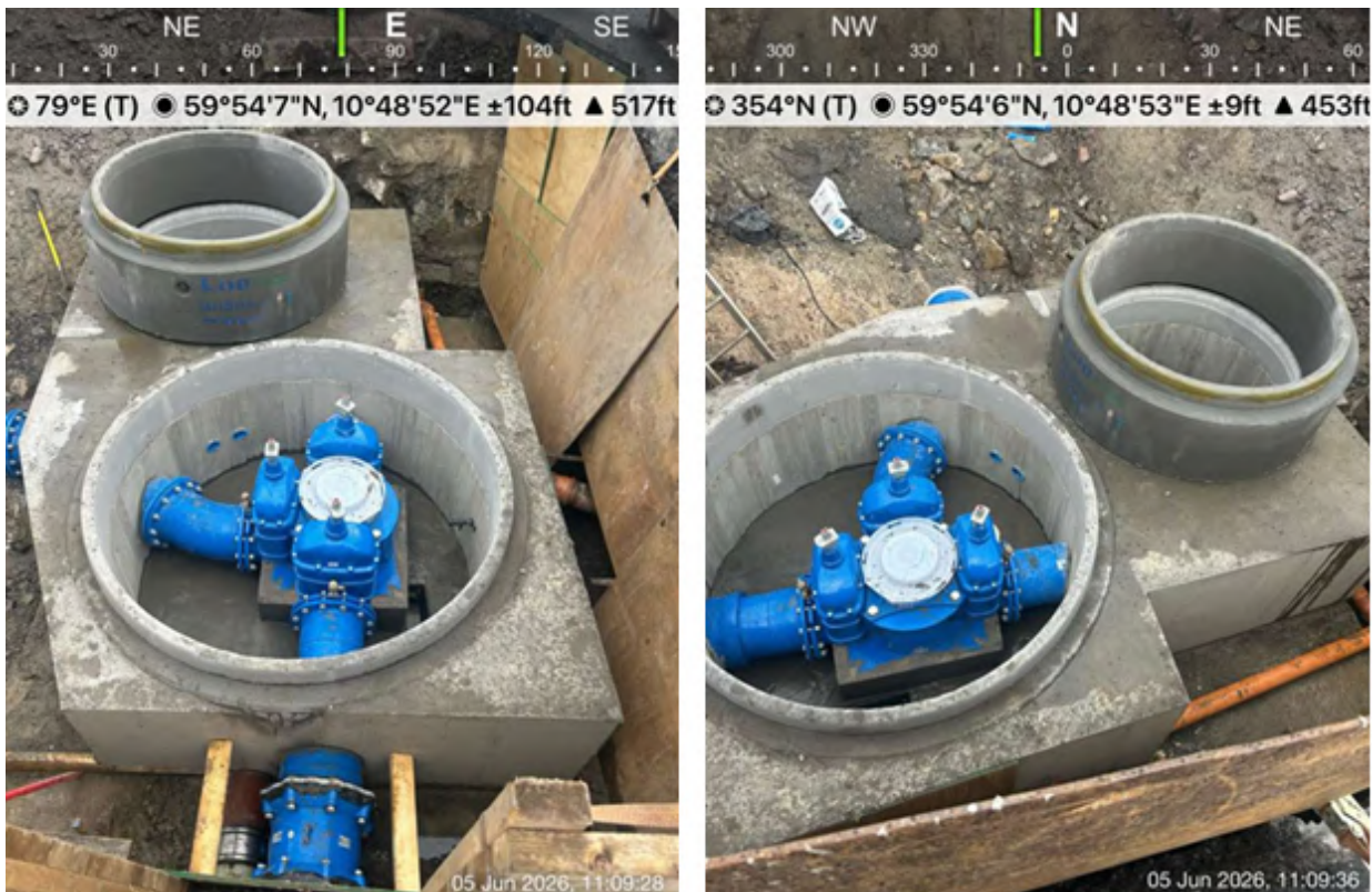
Figur 3: Kumbilder for stop av topplate/montering av kjegle.
