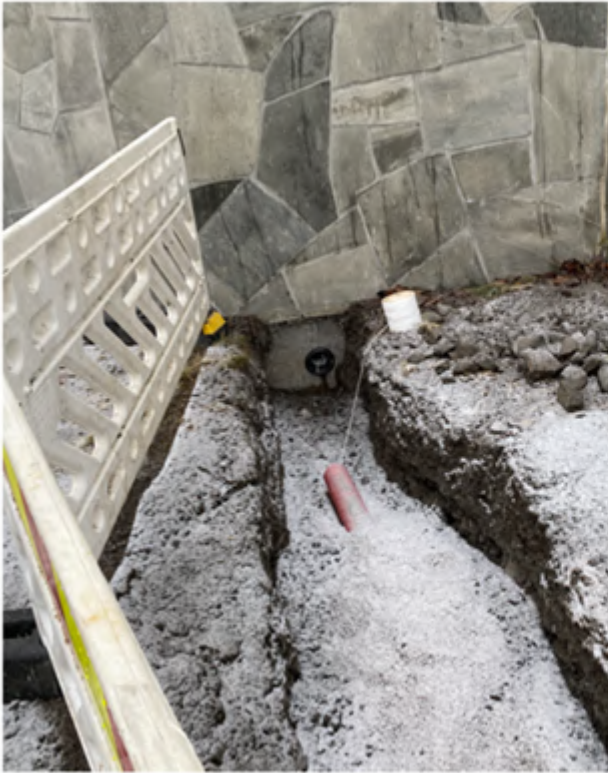
Figur 15c: Påkoblingspunkt. Figur 15d: Kabelmarkering.
