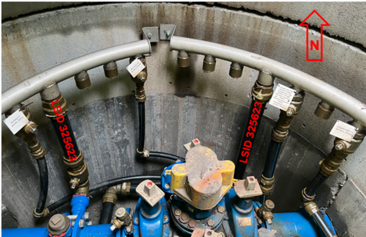
Figur 5: Manifold - bilde av kum med adresseskilt og påskrift av LSID.
