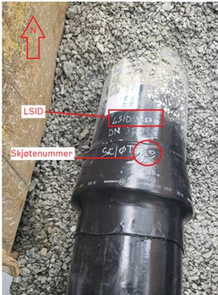
Figur 14: Rør med montert krympemuffe.
