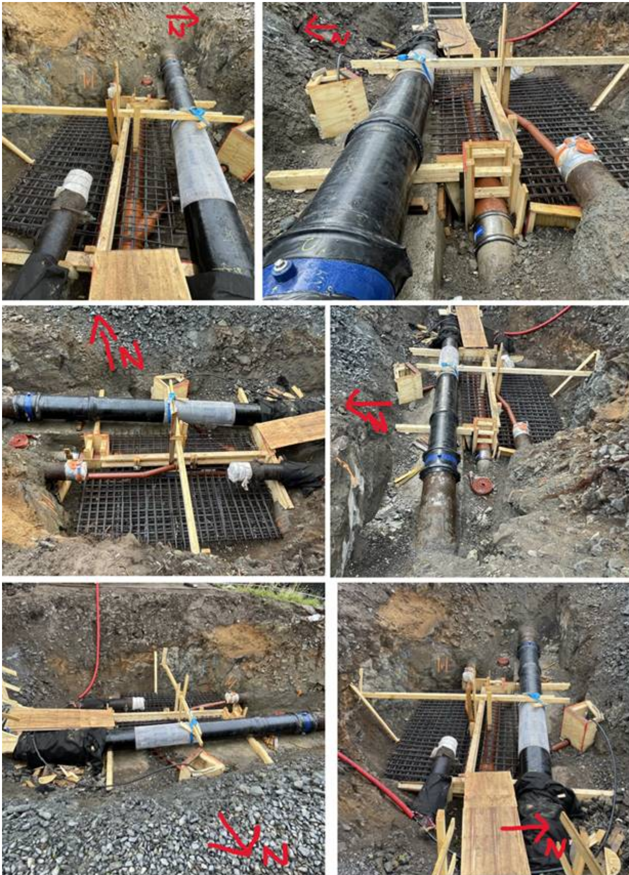
Figur 2: Kumbilder før støp av bunnseksjon.
