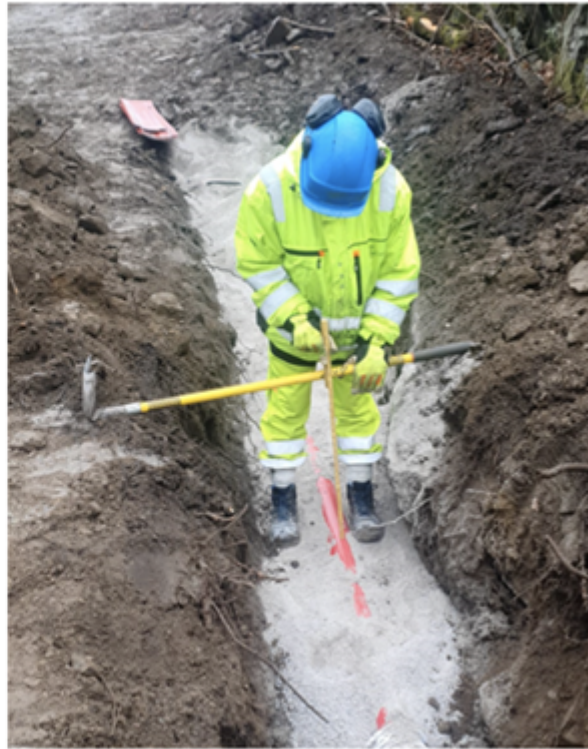
Figur 13b: Dybdemål.
