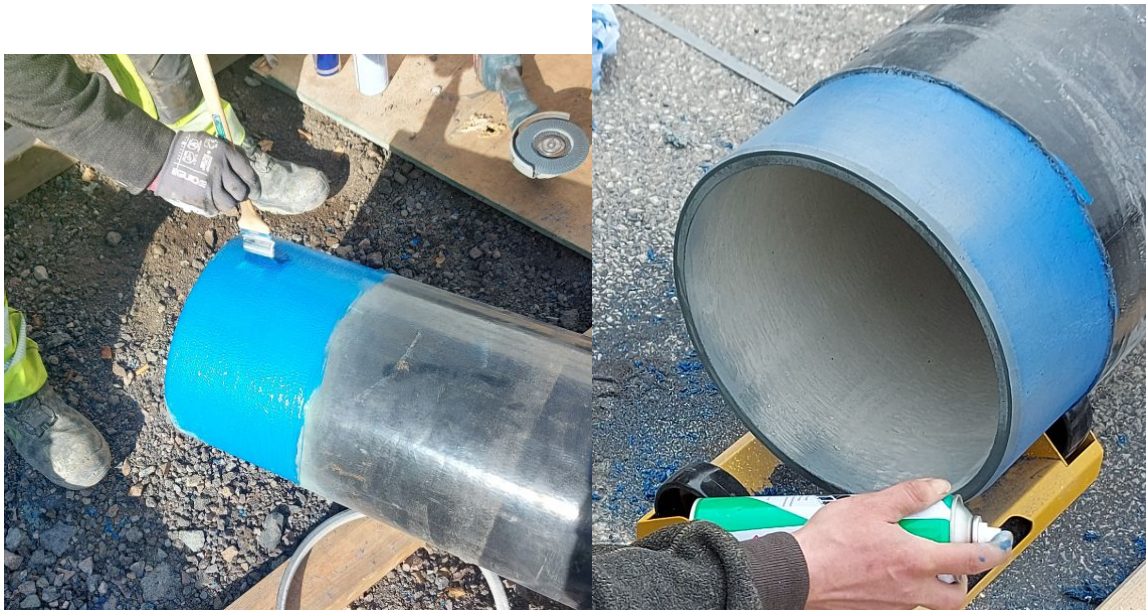
Figur 10: Rør etter påføring av zinkspray og epoxymaling.
