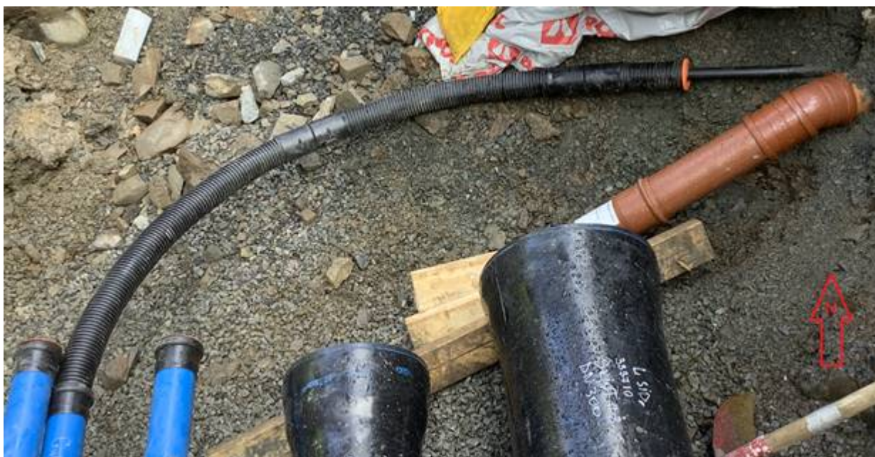
Figur 8: Påkoblingspunkt – stikkledning i varerør.
