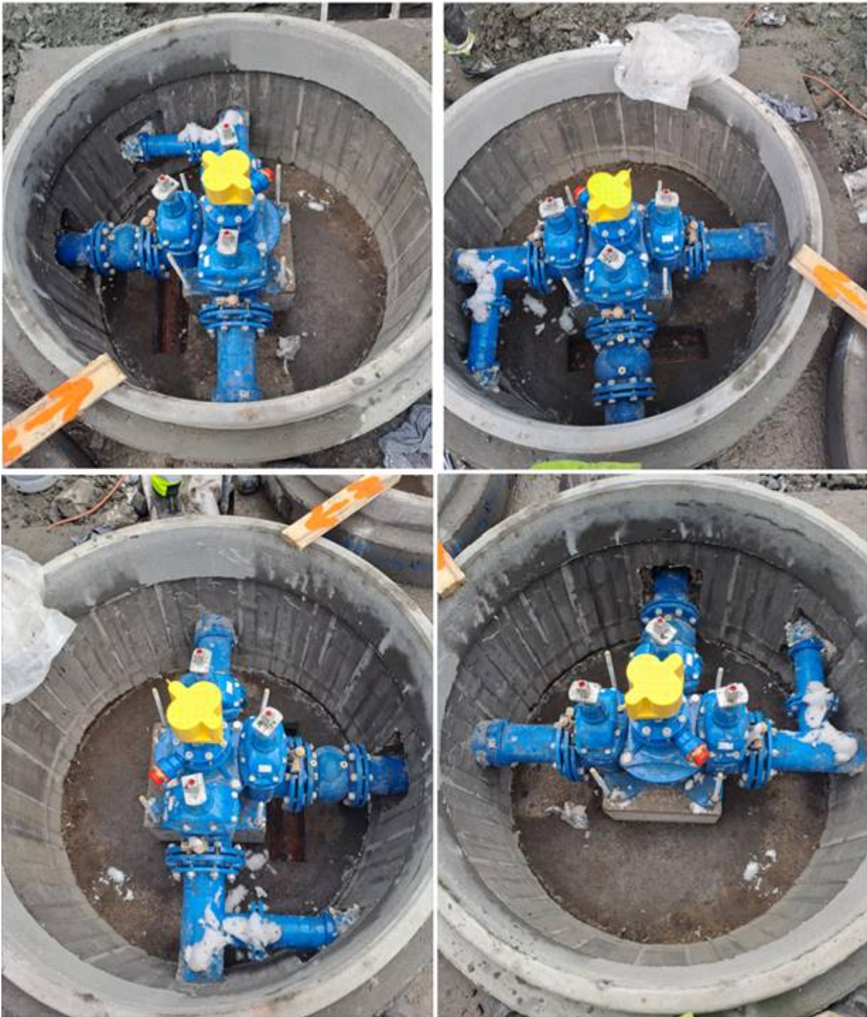
Figur 4: Kumbilder som viser innhold i kum før betongsøylen bygges.
