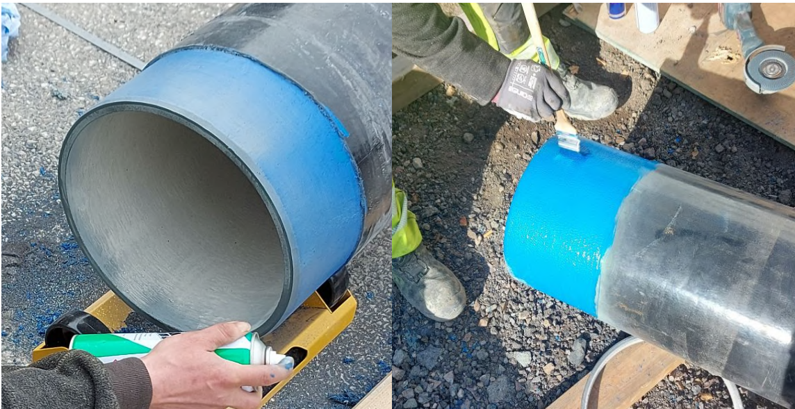
Figur 13: Rør etter påføring av zinkspray og epoxymaling.
