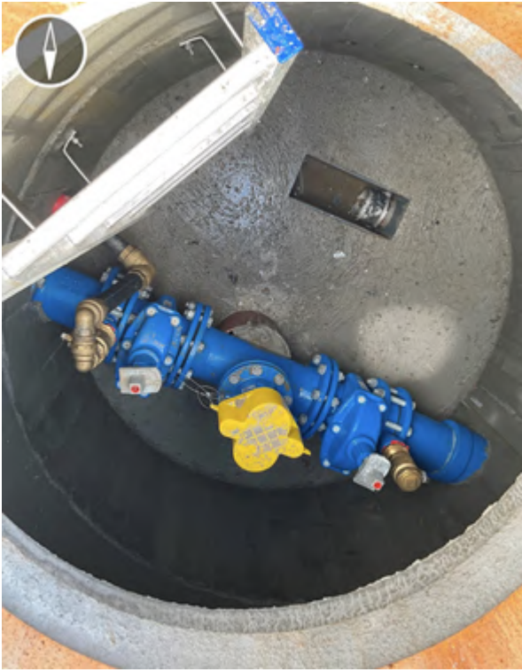
Figur 4: Ferdig etablert kum.
