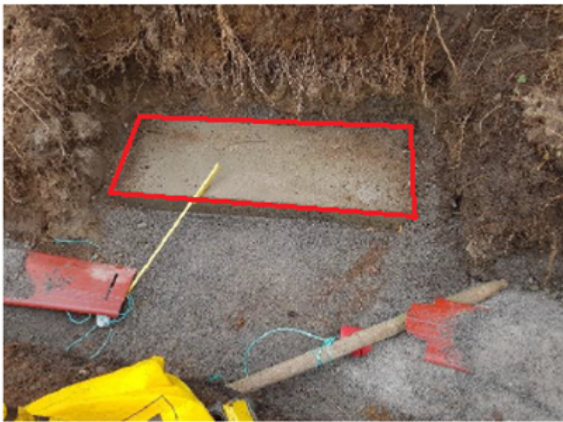
Figur 22: Fundament for skap.
