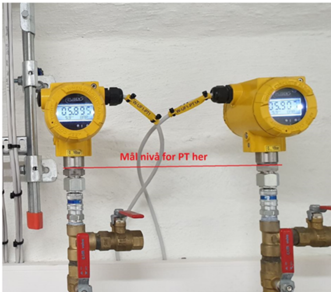
Figur 19: Typiske trykkceller og hvor det skal måles på disse.
