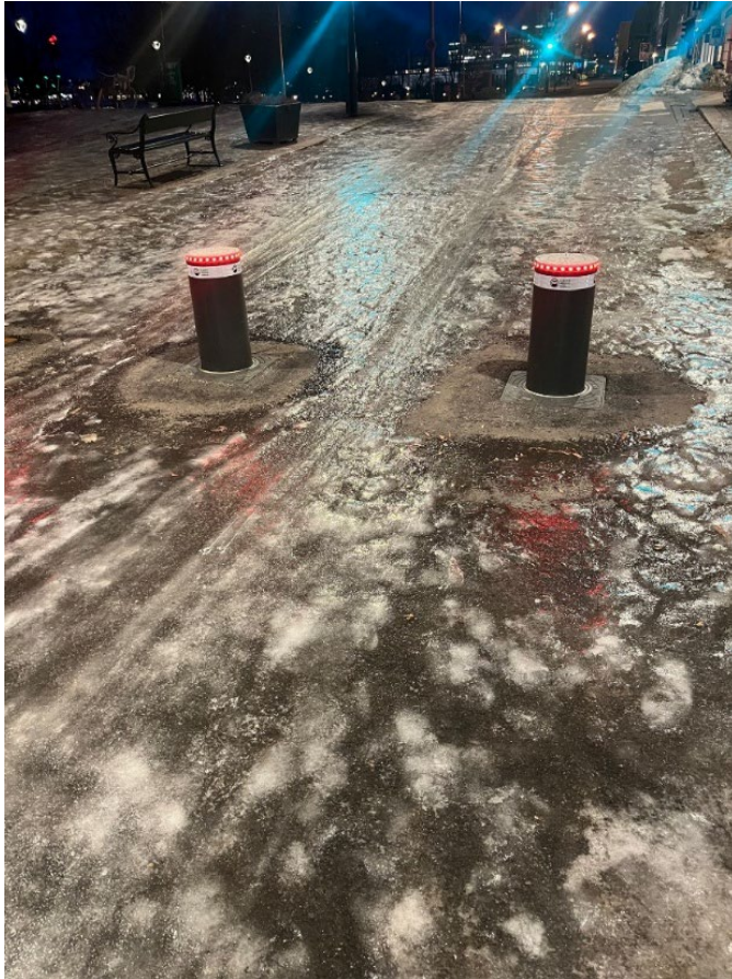
Hålkeføre i en sykkelpassasje i Rådhusgata.
