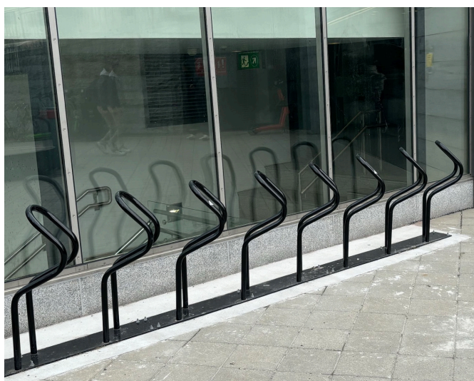
Figur 2.1 og Figur 2.2 Illustrasjon av ulike stativtyper. til venstre vises den svært mye brukte "Publicus", mens til høyre vises stativtypen Bymiljøetaten anvender, "A-stativ". (bilder tatt av Norconsult)
