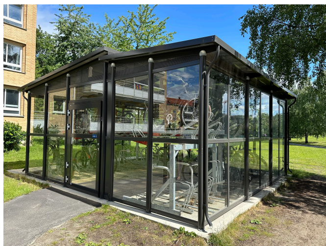
Figur 4.16 Etablering av sykkelkur i glass i Hovin borettslag. Dette er ett av til sammen tre skur, med til sammen omtrent 80 plasser som er etablert i senere år, blant annet gjennom kommunale midler. (bilde tatt av Norconsult)
