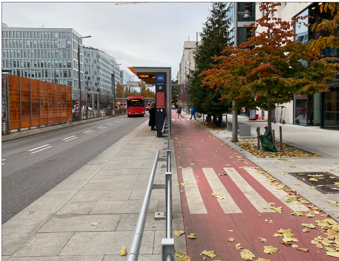
Figur 6-1 Fotografi som viser bruk av ledegjerde mellom sykkelfelt og holdeplass i Bjørvika i Oslo. Foto: Asplan Viak.
