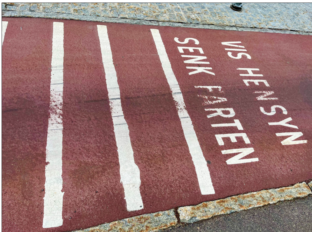
Figur 7-1 Rumlestriper og oppmerket tekst for å få syklende til å redusere hastigheten og være oppmerksomme på gående. Foto: Bymiljøetaten.
