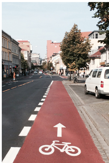
Foto 13: Bredt sykkelfelt i Grønlandsleiret. Dersom gateparkering må etableres på innsiden av sykkelfelt, skal det være en buffersone på minst 0,5 m av hensyn til syklisters sikkerhet (foto: Andenes).
