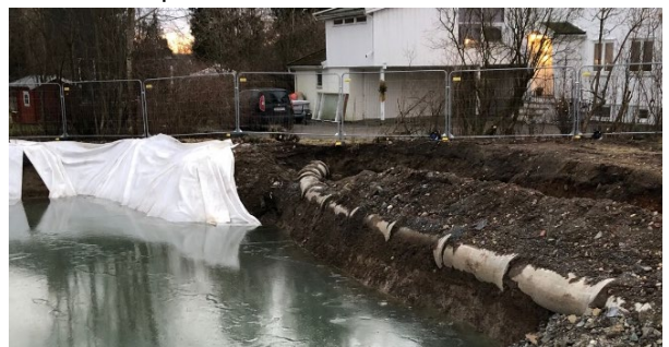
Figur 4: Betongrøret på bildet er en lukket bekk. Grunnvannsnivået i området vil ofte følge den lukkede bekken. Når rørene er fulle, vil flomveien renne på overflaten (Foto: Bent Braskerud)
