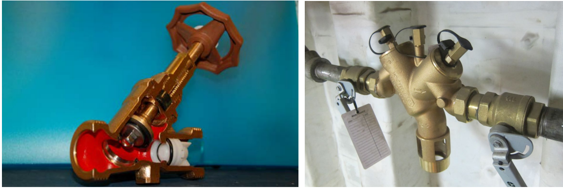
Figur 5: To typer tilbakestrømningsbeskyttelse. Til venstre vises en kontrollerbar tilbakeslagsventil med integrert stoppventil (EA, jf. NS-EN 1717). Testporten er på undersiden mellom den hvite tilbakeslagsventilen og stoppventilen oppstrøms. Denne ventilen aksepteres mot væskekategori 2 (vann som har endret lukt, smak, temperatur eller farge). Til høyre vises en bedre beskyttelse (BA, jf. NS-EN 1717). Slike ventiler beskytter mot væskekategori 3 og 4 (alle typer kjemisk forurensning). NB: BA-ventiler må monteres horisontalt med dreneringen ned, og det skal være luftgap mellom drenering og avløpsrør. Det skal monteres stengeventil før og etter BA-ventilen (nødvendig for kontroll og vedlikehold), og noen typer trenger et filter i forkant. Mot vann som kan være forurensset av smittestoff bør det være luftgap. Alle barrierer må kunne testes/verifiseres. (Foto: Eyvind Andersen)
