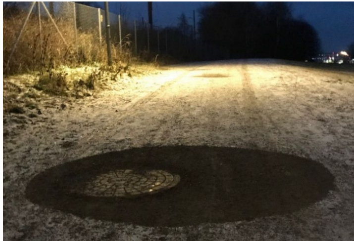
Figur 2: Plasseringen av ledninger kan ikke bedømmes på grunnlag av kart alene. Ledninger er ikke alltid presist stedfestet. Utstyr som kummer er punktmarkert, med utgangspunkt i kumlokkets plassering. Som vist her, så ligger kumlokket sjelden midt i kummen; snøen har smeltet over kummen (Foto: Eyvind Andersen)
