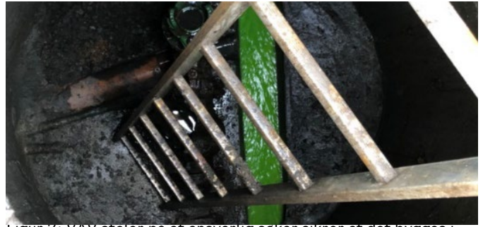
Figur 7: VAV stoler på at ansvarlig søker sikrer at det bygges i samsvar med tillatelsen. Noen ganger foretar likevel VAV kontroller. Her er fargeprøving brukt til å avdekke ulovlig tilkobling av takvann til avløpsledning. Grønn farge er tilsatt taknedløp, og spores i kum nedstrøms (Foto: Kjell Pedersen)
