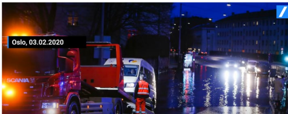
Figur 1: Da en 400 mm vannledning ble gravd over fosset det ut 3000 liter vann i sekundet. Akerselvas minstevannføring er til sammenlikning 1000 l/s. Med flom i gatene og oversvømte kjellere ble kostnadene store (Faksimile: abc nyheter)
