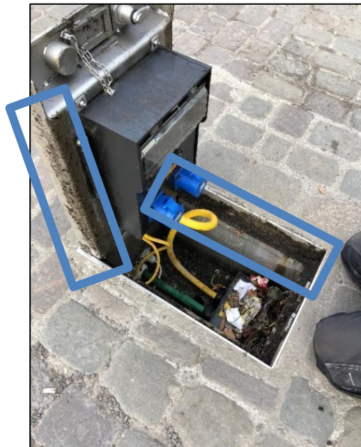
Figur 5: Kanter må rengjøres ved åpning/lukking
