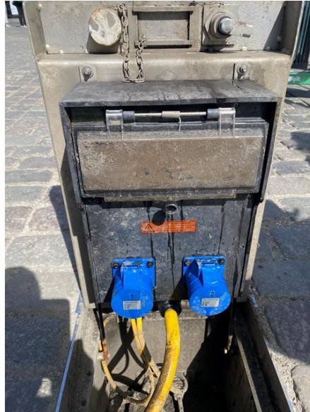
Figur 10 – Resultat av utilstrekkelig lukket deksel
