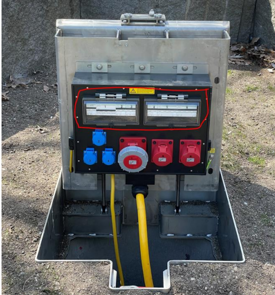
Figur 9 – Vern bak rent beskyttelsesdeksel
