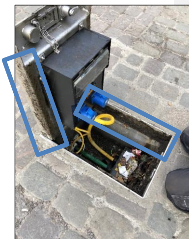
Figur 5: Kanter må rengjøres ved åpning/lukking
