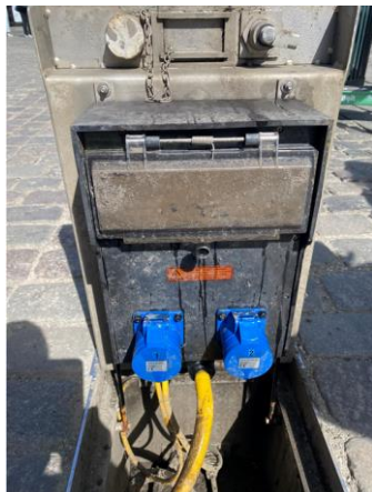
Figur 10 – Resultat av utilstrekkelig lukket deksel
