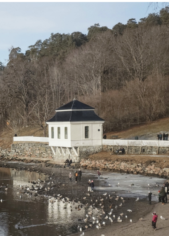
Historiske murer har stor verdi. Hvervenbukta
