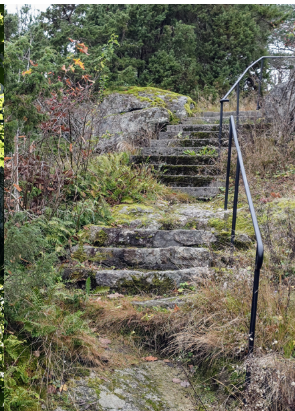
Hagetrapp med smijernsrekkverk
