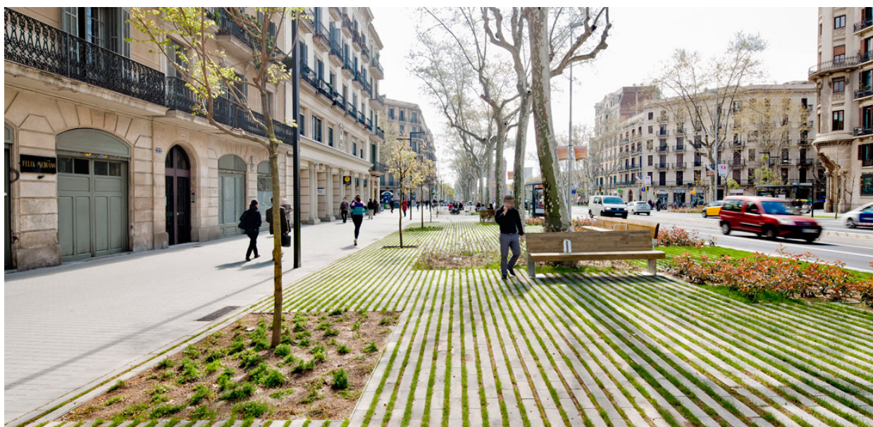
Figur 54: Eksempel på permeabelt dekke fra Passeig De St. Joan Boulevard i Barcelona (Foto: Adriana Goula).
