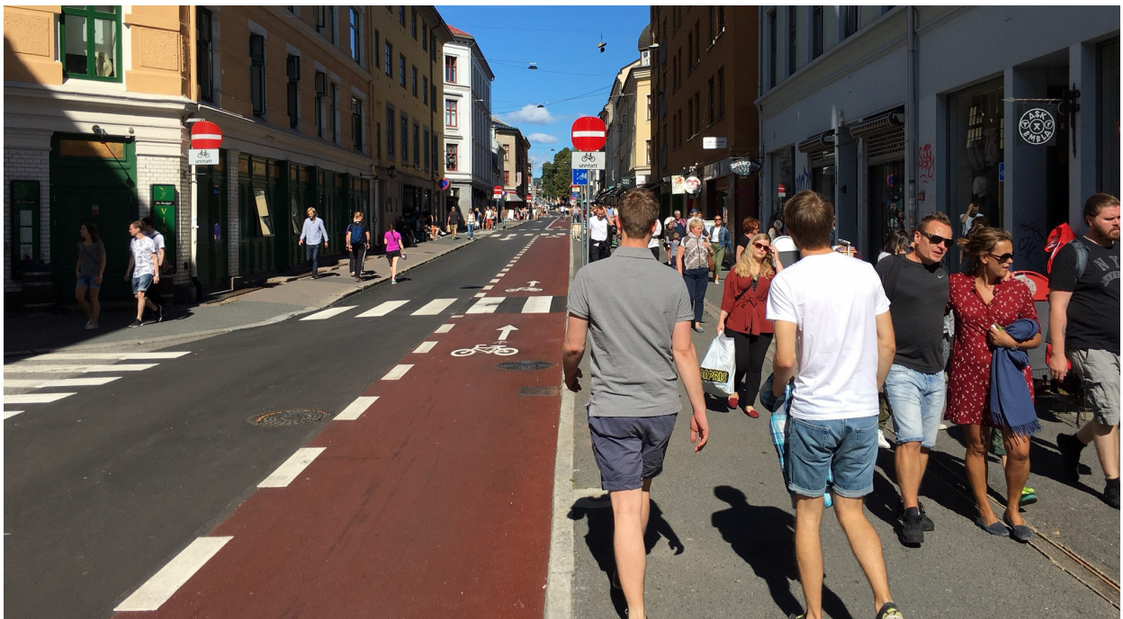
Figur 19: Bildet viser ny sykkel løsning i Markveien. Gata er tilrettelagt med sykkel felt mot kjøreretningen og sykling i blandet trafikk med kjøreretningen.
