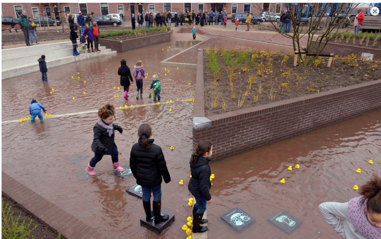
Figur 55: Eksempel på fordrøyningsareal utformet som lekepark, Waterplein Benthemplein i Rotterdam.
