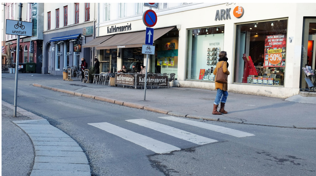
Figur 18: Bildet viser utbedret rampe fra fortau til gate i Thorvald Meyers gate.
