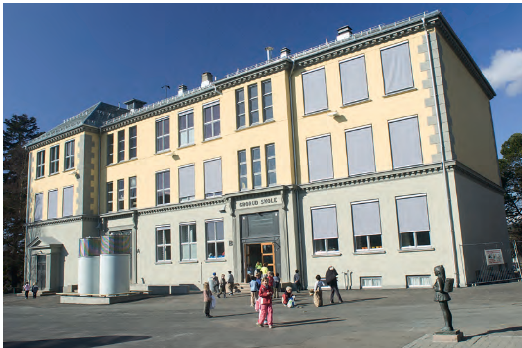
Det gamle skolebygget på Grorud, med første byggetrinn i 1900, var ferdig rehabilitert i 2004.
