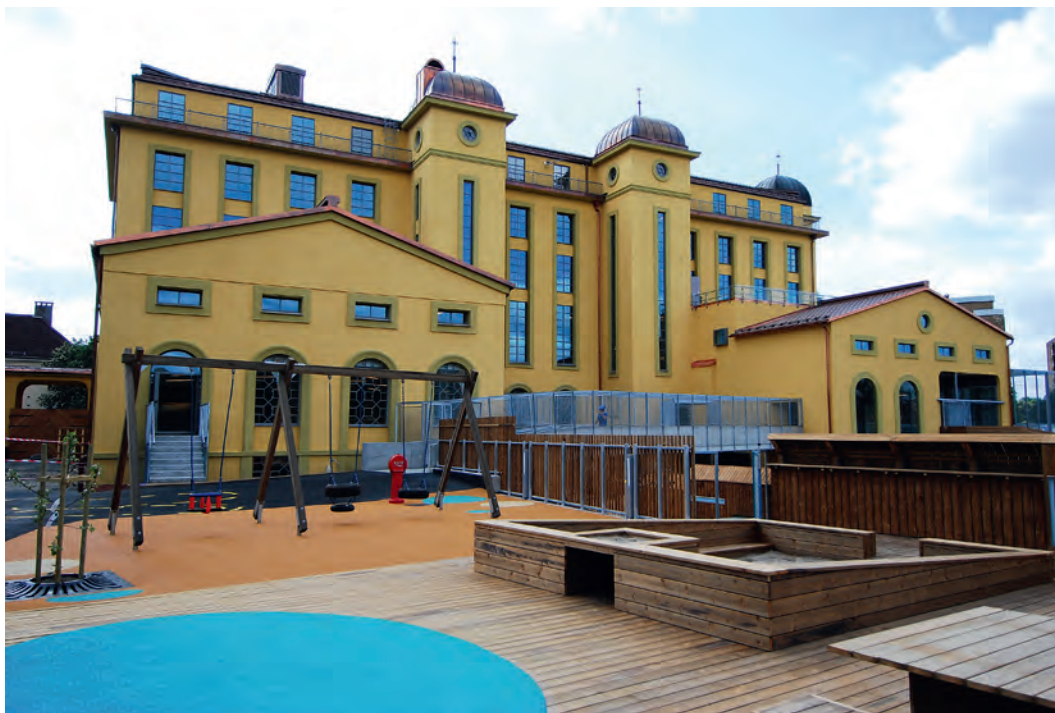
Margarinfabrikken barnehage på Bjølsen åpnet i 2010. Den ombygde fabrikken fra 1920-tallet, og et nyere tilbygg, er i dag barnehage for nesten 500 barn.
