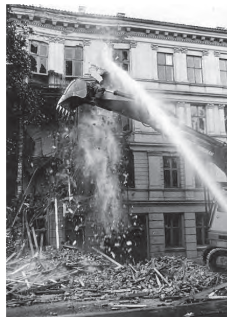
Gravemaskin river gammel bygård, Nordre gate 4, i 1987. Vanningen er for å dempe støvet.
