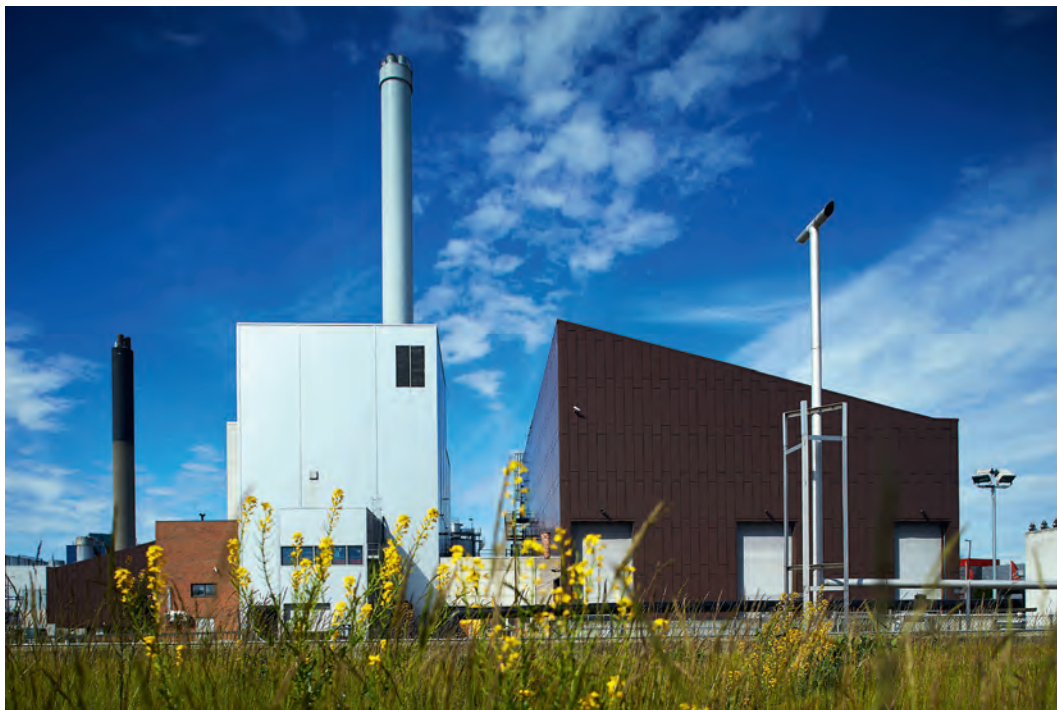
Haraldrud varmesentral – næringsavfallsskjelen (brun del) ble etablert i 2000.
