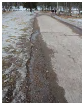
Langs den asfalterte turveien kan renner med lys stein fungere som både renne og ledelinje.
