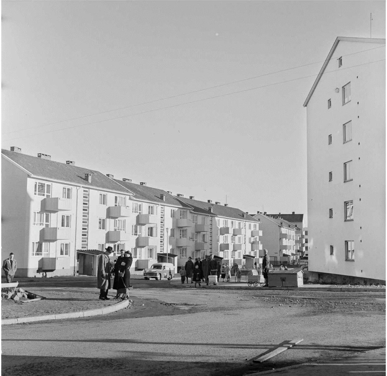
Marmorberget borettslag (Antenneveien fra Østerliveien) på Lambertseter. Tre etasjer, små balkonger og saltak, helt typisk for OBOS-bebyggelsen. Marmorberget ble tegnet av arkitekt Erling Viksjø. Foto: Leif Ørnelund, ca. 1956. Oslo Museum.
