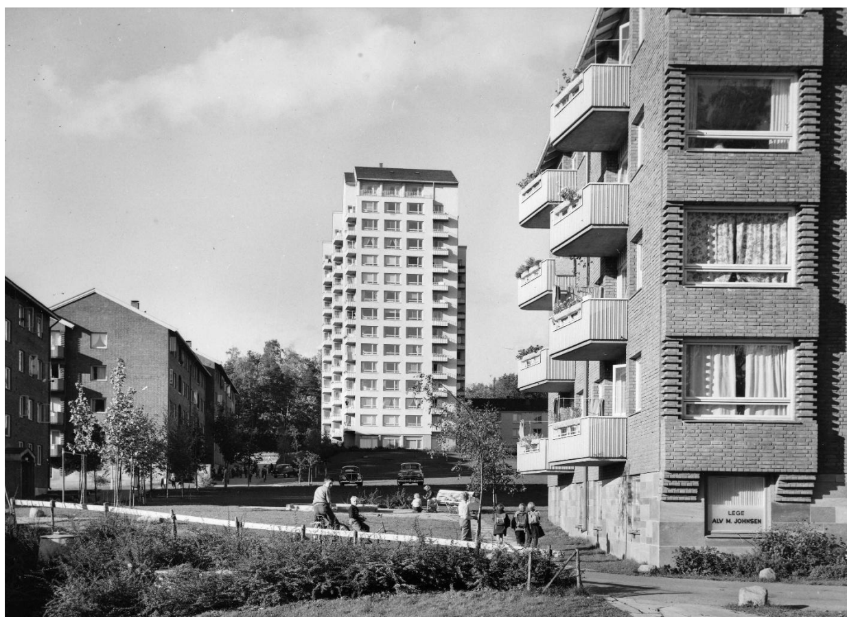
Hoff terrasse ble bygget ut fra 1949 av entreprenør Nils Stiansen, etter tegninger av arkitektfirmaet Torp og Torp. Utbyggingen var privatfinansiert og bestod av lamellbebyggelse med fasader i frilagt tegl og punktblokk i pusset mur. Punktblokken hadde næringslokaler i sokkeletasjen. I toppleiligheten bodde Trygve Lie. Foto: Mittet & Co, 1955-1960. Oslo Museum.
