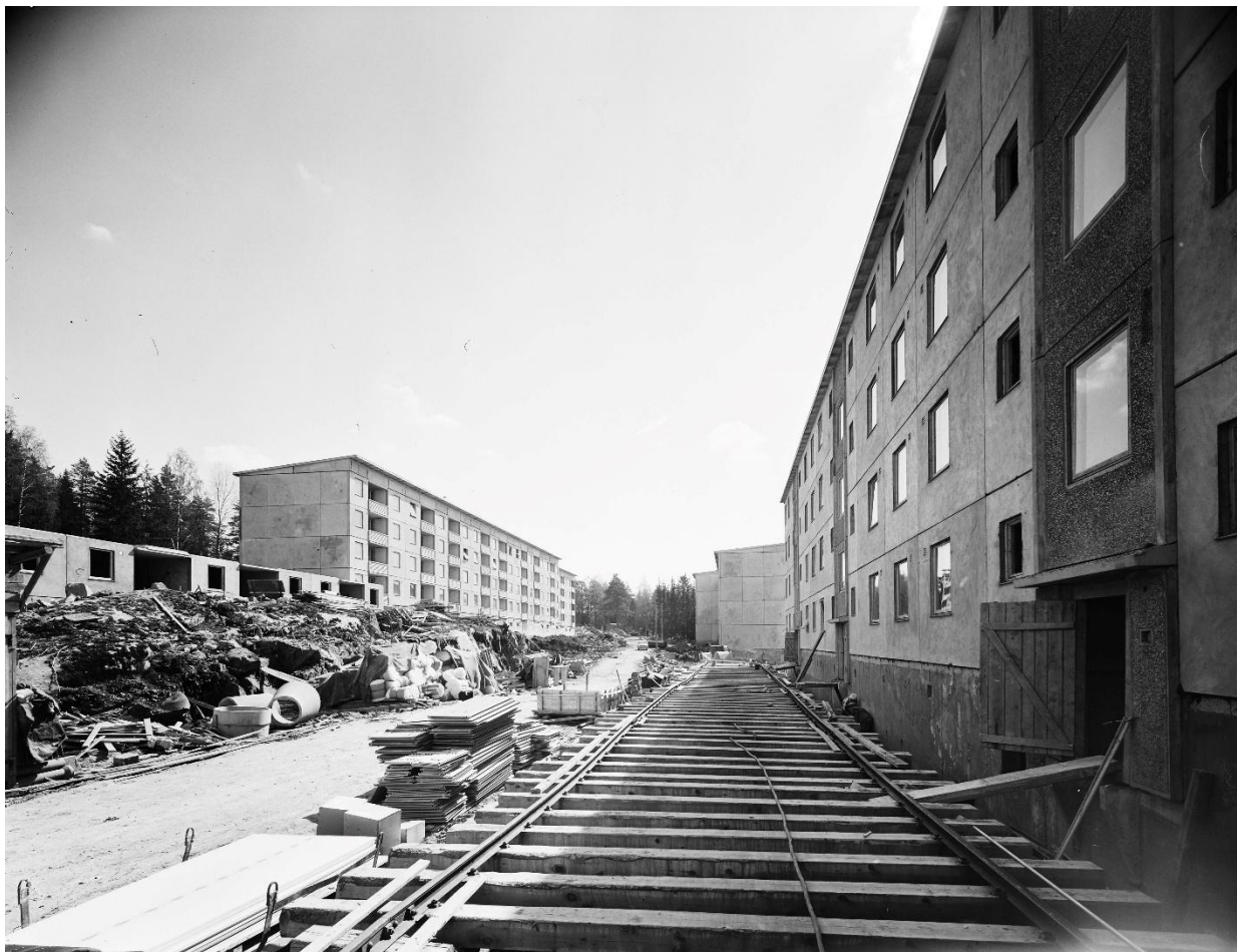
Skinnegående kraner ble brukt for å heise på plass prefabrikkerte elementer. Planlegging for bruk av kraner og kranbaner/skinnegang la føringer for hvor bygninger ble plassert i terrenget og i forhold til hverandre, noe som favoriserte frittliggende lamellbebyggelse. Her fra USBLs utbygging i Olav Nygards veg på Ulsrud. Foto: Leif Ørnelund, 1961. Oslo Museum.
