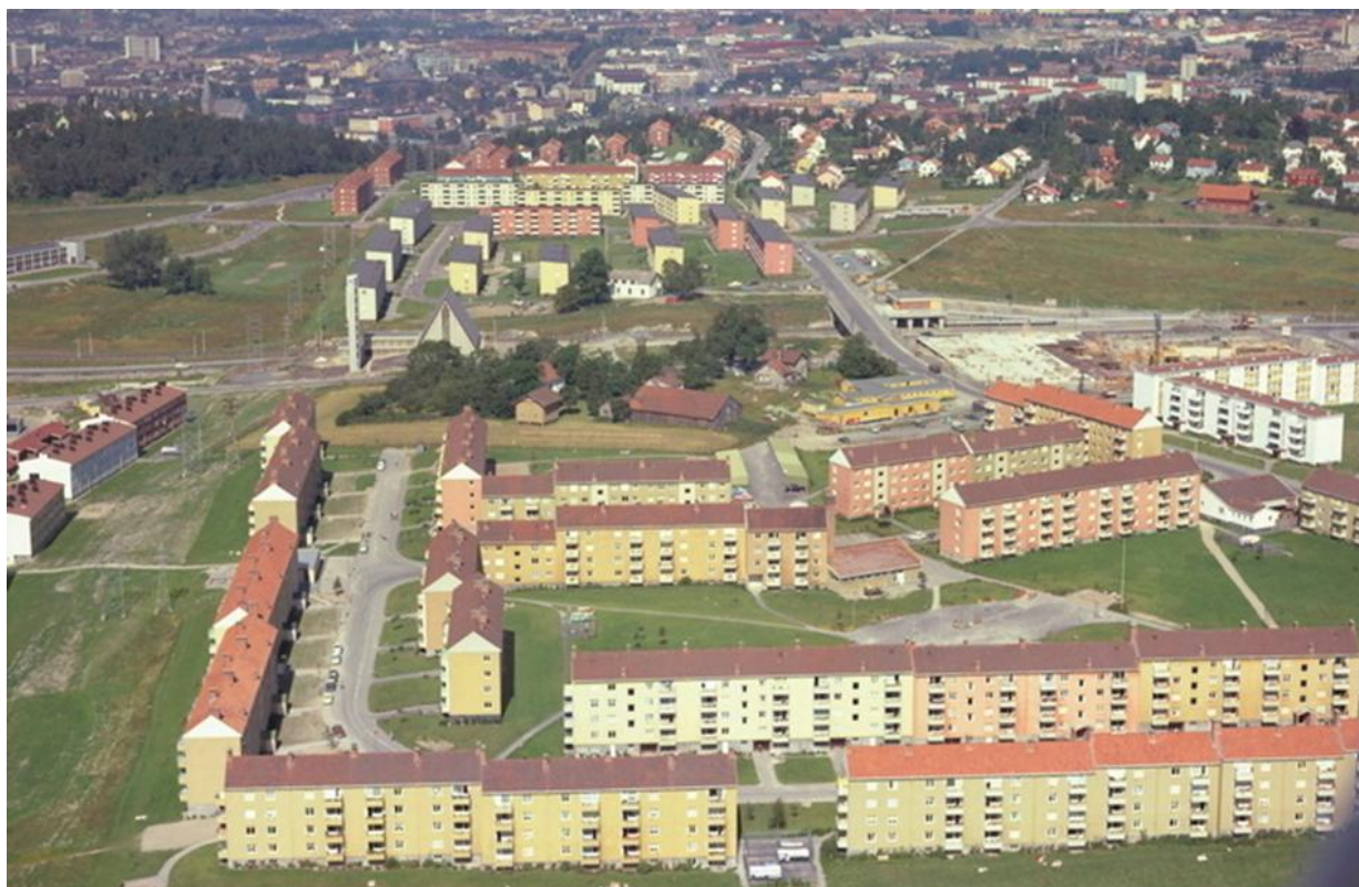
Typiske OBOS-blokker på Manglerud. Den gamle gården er bevart (ca. midt i bildet) og kirken er oppført, mens shoppingsenteret ikke står ferdig. Forstadsbanen (snart t-bane) går tvers gjennom området. På den andre siden av skinnene ligger Plogveien borettslag fra slutten av 1950-tallet, bestående av blokker med pulttak, og bakenfor der igjen det eldste borettslaget på Manglerud fra 1940-tallet. Foto: Widerøes Flyveselskap/Ukjent, 1964. Oslo Byarkiv.
