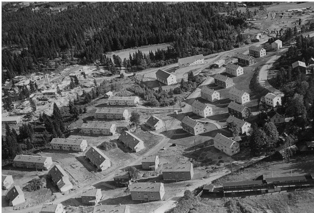
Dugnadsbygde rekkehus og flermannsboliger i Selvbyggerveien på Årvoll. Foto: Widerøes Flyveselskap/Rolf Ingelsrud, 1952. Oslo byarkiv.
