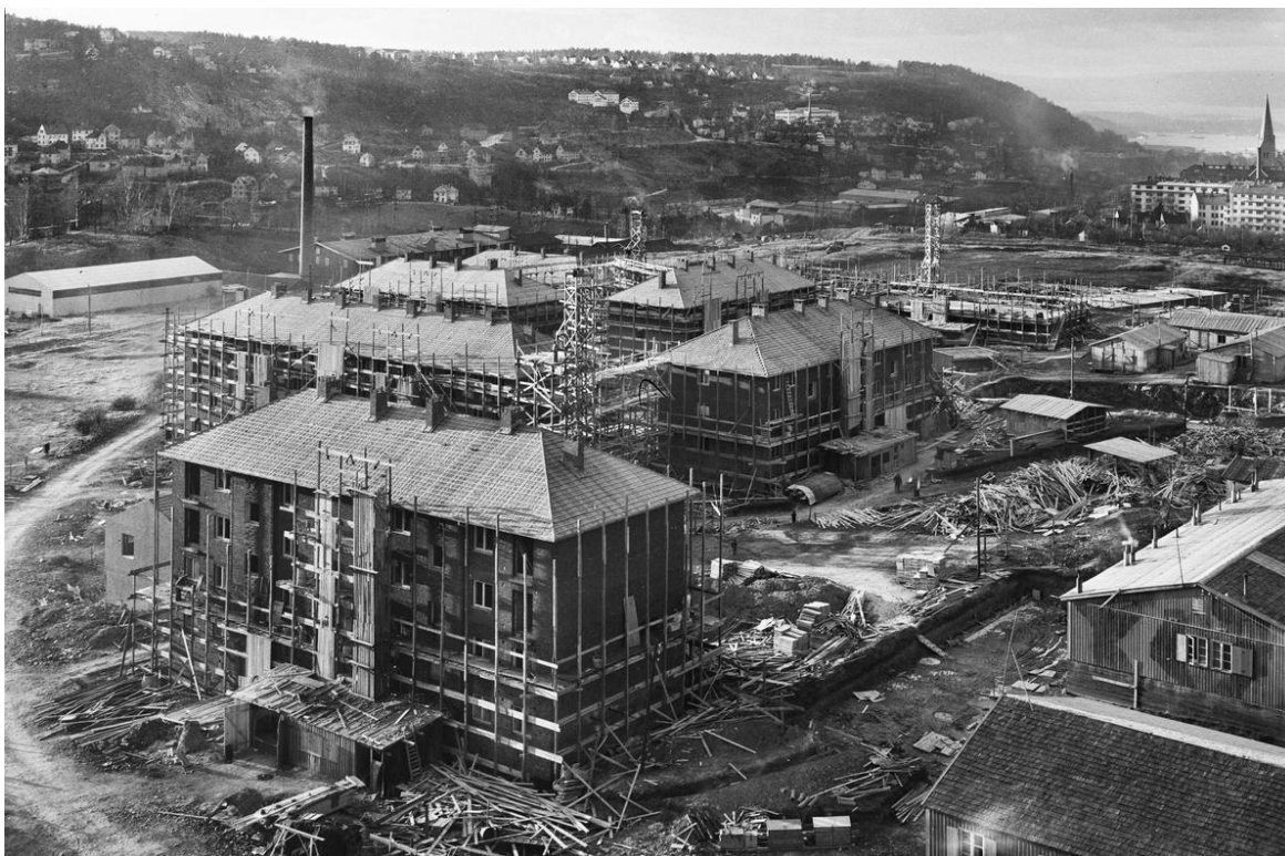
Lamellblokker på Etterstad under bygging i 1949. Ekebergåsen og Vålerenga kirke i bakgrunnen. Foto: Leif Ørnelund, 1949. Oslo Museum.
