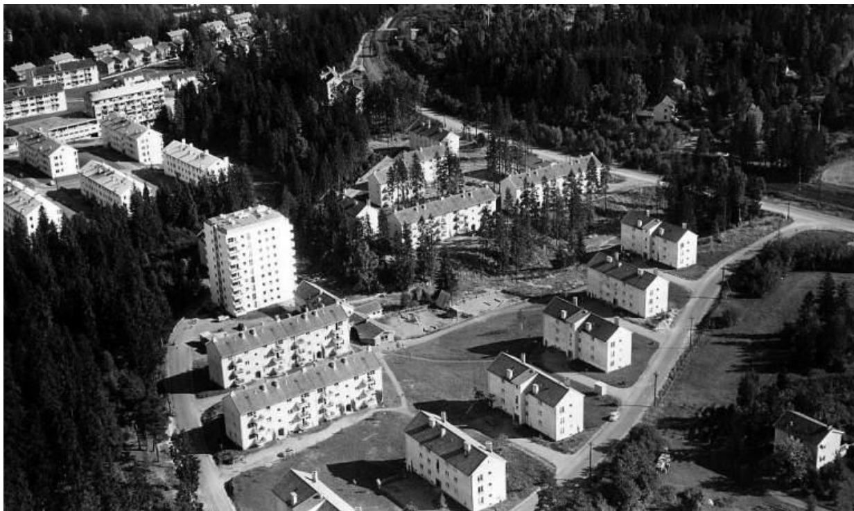
Borettslaget Snippen på Holmen i Vestre Aker ble oppført for Luftforsvarets byggelag i 1946-1948 etter tegninger av arkitekt Erling Viksjø. Anlegget er ett av få anlegg i prosjektet som både er kommunalt listeført på Byantikvarens gule liste og foreslått videreført som hensynssone bevaring av kulturmiljø i kommuneplanens arealdel. De enkelte bygningene i anlegget er svært godt bevart, og de åpne, grønne fellesarealene er viktig for å ivareta anlegget som kulturmiljø. Foto: Widerøes Flyveselskap/Vilhelm Skappel, 1953. Oslo Byarkiv.
