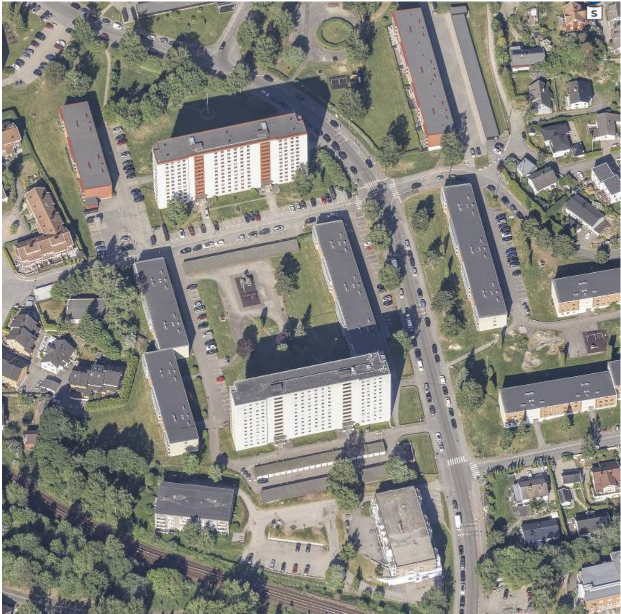
Ved utbyggingen på Rødtvet ble det lagt til rette for privatbilisme og parkering i direkte tilknytning til boligblokkene, med garasjerekker og parkeringsplasser på terreng langs grøntarealene mellom blokkene og gi tilknytning til innganger. Foto: BlomUrbex 2023. Hentet fra Oslo kommunes planinnsyn.
