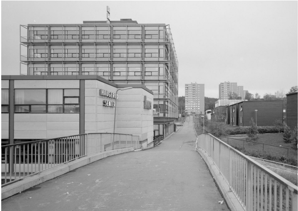
Haugerud fotografert fra gangbroen ved t-banestasjonen. Haugerud senter til venstre. Utbyggingen på Haugerud bestod av ni punktblokker i 12 etasjer, kombinert med mindre blokker, småhus og bilfrie gangveier gjennom boligområdene. Foto: Teigens fotoatelier, 1970. DEXTRA Photo/Norsk Teknisk Museum.
