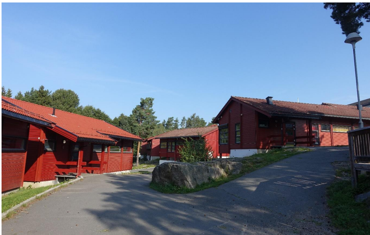
Rosenholm skole er prioritert for vern i Verneplan for Osloskolene. Skolen ble oppført i 1984/1988 som del av Holmlia-utbyggingen. De frittliggende skolepaviljongene er typiske for 1980-tallets skoleanlegg. Skolen ble tegnet av arkitektene Abrahamsen og Grinde i samarbeid med Moelven Brug og er bygget av prefabrikkerte moduler. Samme skoletype ble oppført på Mortensrud og Bjørndal. Foto: Byantikvaren, 2020.
