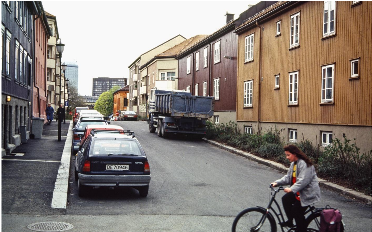
Byfornyelsesprosjekt i Stolmakergata tegnet av arkitekt Truls Thorenfeldt og oppført av OBOS i første halvdel av 1980-tallet. Den nye boligbebyggelsen bestod av trehusene til høyre i bildet (Stolmakergata 9h og j) og lavblokker i mur på begge sider av Stolmakergata. Den eldre bebyggelsen mellom Nordre gate og Øvre gate på Grünerløkka bestod av lav trehusbebyggelse fra før byutvidelsen i 1859. Trehusbebyggelsen ble revet i flere etapper i løpet av etterkrigstiden. Øvre gate 2b og Stolmakergata 8 (til venstre i bildet) er rester av 1800-tallsbebyggelsen. Foto: Petter Maus, ca. 1990. Oslo Museum.
