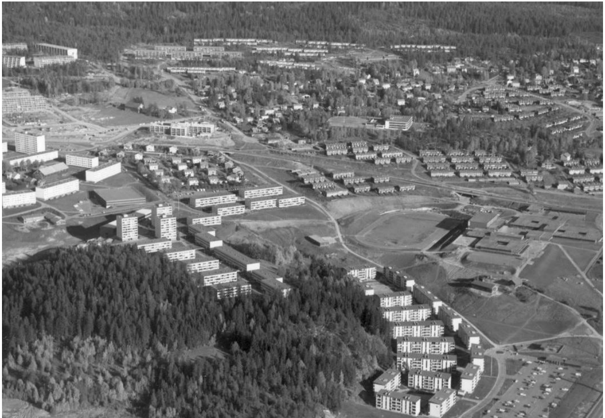
Stovner/Fossum, Vestli, Smedstua og Stigenga ble bygget ut etter Tokerudplanen. I høyre bildekant ser man også Smedstua og Haugenstua skoler, og flere områder med rekkehus samt Stovner skole bakenfor. Foto: Fjellanger Widerøe, 1972. Oslo byarkiv.
