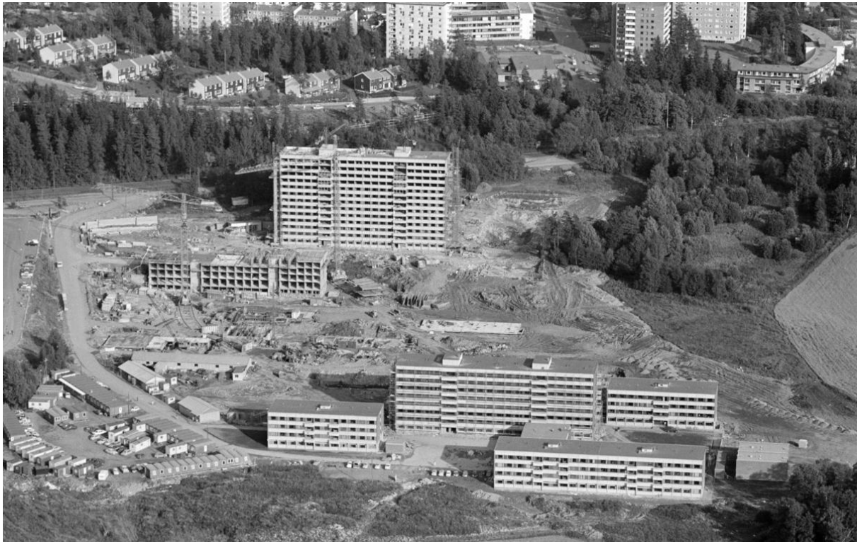
Kringsjå studentby under oppføring. De bærende konstruksjonene i betong er synlige på blokkene som bygges. Nede til høyre blokkbebyggelse med ferdigstilte fasader med tidstypisk, langsgående brystninger med balkonger og vindusbånd. Gjennom hele etterkrigstiden ble det oppført boligområder med blokker tilrettelagt for spesifikke grupper, så som studentbyene på Sogn og Kringsjå, men også søsterblokker knyttet til sykehusene o.l. Alderstrygdeboliger ble som regel integrert i drabantbyene. Foto: Ukjent, 1968. Arbeiderbevegelsens arkiv og bibliotek.
