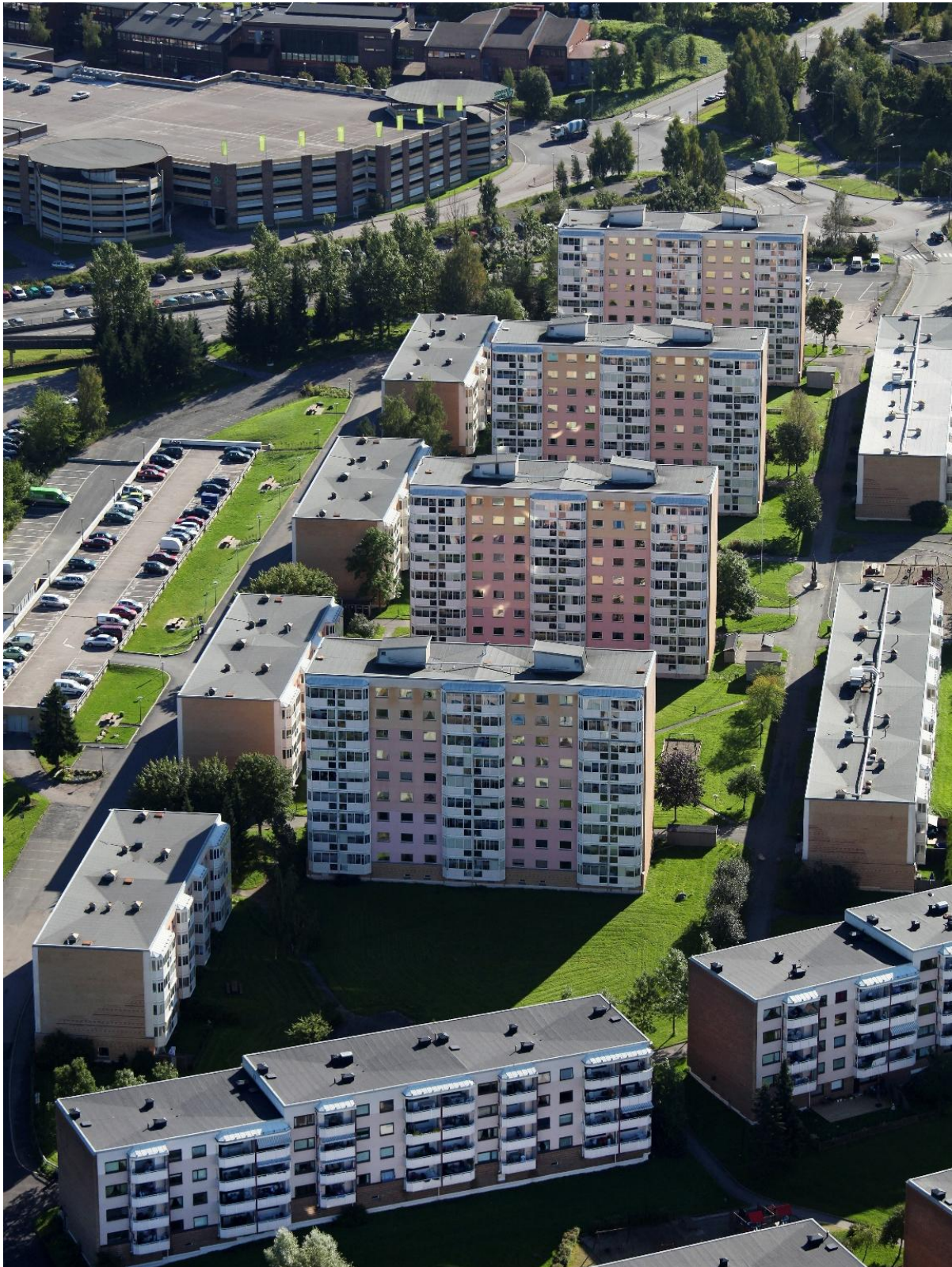
Høy- og lavblokker i Tante Ulrikkes vei på Stovner, med Stovnersenteret i bakgrunnen. Åpne grøntarealer mellom blokkene og felles garasjeanlegg i utkanten av boligbebyggelsen er typisk for de store boligutbyggingene fra 1960-tallet og fremover. Formålet var å skille bilister og myke trafikanter. Foto: Rune Nylund.
