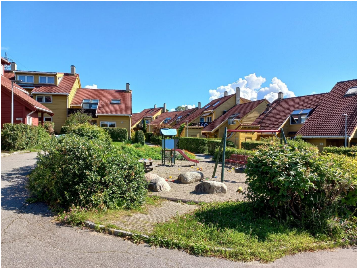
Øvre Sogn borettslag (arkitektene Borgen og Bing Lorentzen for OBOS, 1985-1988). Anlegget ble oppført mot slutten av perioden som massebyggeriprojektet har kartlagt. Tett-lav boligbebyggelse og bilfritt miljø i tråd med idealene fra 1970- og 1980-tallets massebyggeri. Foto: Byantikvaren, 2024.
