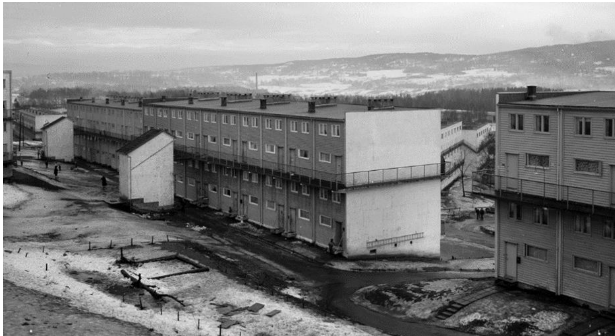
Selvaags altangangblokker på Veitvet ble oppført etter samme prinsipp som altangangblokkene på Bestum. Den elegante, åpne spiraltrappen fra Bestum fikk Selvaag ikke bruke på Veitvet. Her ble det isteden benyttet enkle, lukkede, utenpåliggende trapperom. Foto: Leif Ørnelund, 1959. Oslo Museum.
