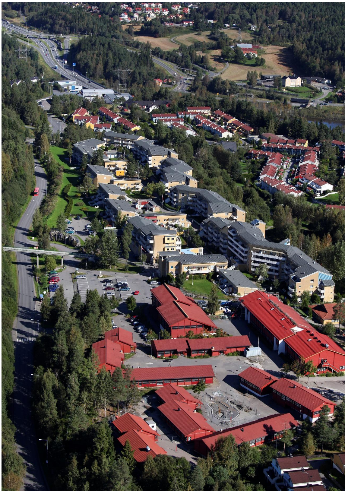
Bjørndal senter og Bjørndal skole sett fra sør. Småhusbebyggelsen i Nyjordveien og Nyjordstubben nord og nordøst for senterbebyggelsen ble oppført av USBL og murmester Trygve Brudevold. Foto: Rune Nylund.
