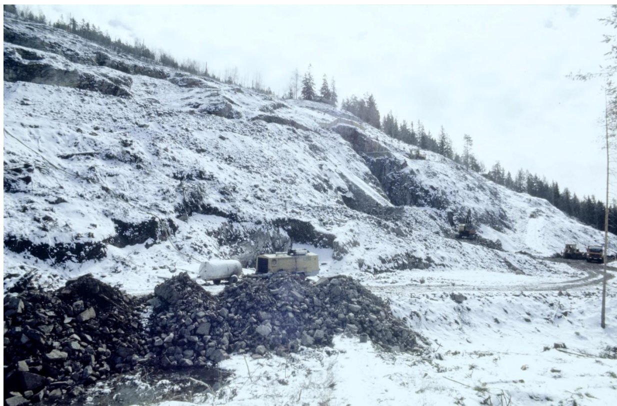
Klargjøring av byggetomter i Voksenkollen. Selvaag bygget terrasseblokker i det bratte terrenget. Foto: Atelier Rude, 1980. Oslo Museum.
