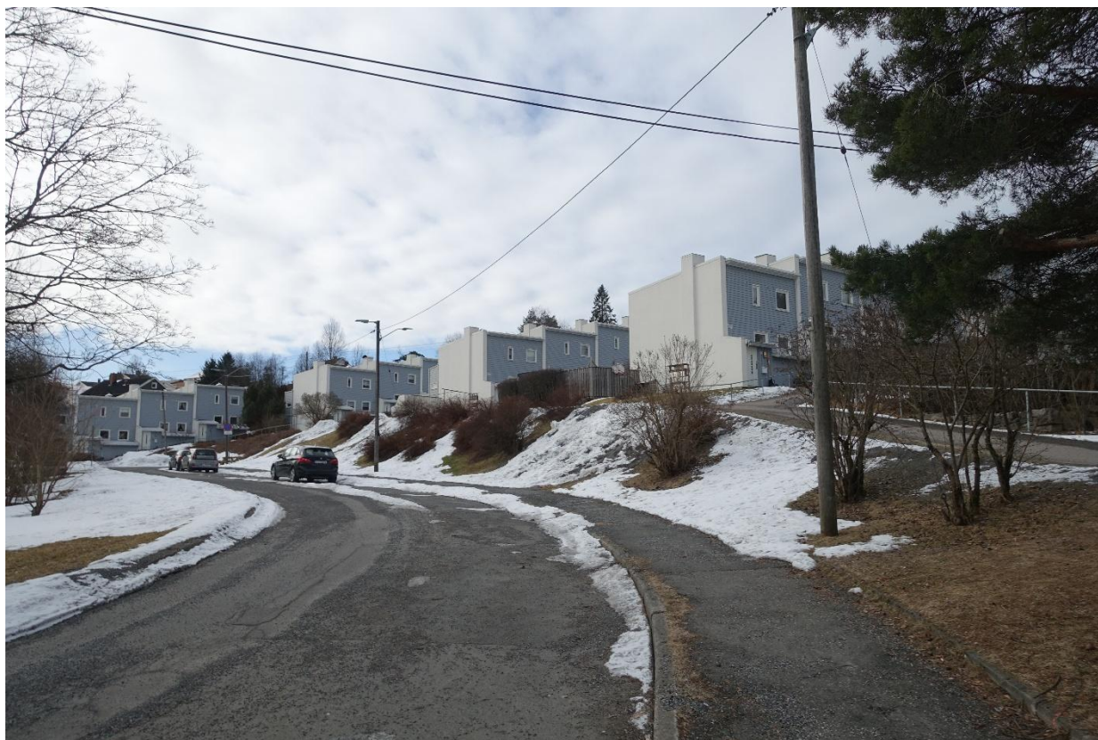
Rekkehus i Vekterveien, bygget i sonen for åpen bebyggelse og rekkehus i reguleringsplanen for Manglerud fra 1952. Disse rekkehusene ble byggemeldt først litt inn på 1960-tallet, noe som er synlig i det arkitektoniske formspråket. Ferdigstillingen av drabantbyene tok tid, og selv om planen er typisk for 1950-tallet, kan arkitekturen strekke seg inn i et nytt tiår. Foto: Byantikvaren, 2019.
