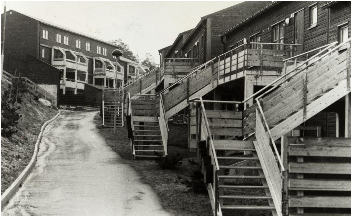
I USBLs utbygging av Asperud på Holmlia ble kostnader til leilighetene nedskalert gjennom forenkling av materialbruk og utstyr. Mursteinsfasader på blokkene ble byttet ut med trekledning og plater. Foto: Vidar Ruud, 1983. Arbeiderbevegelsens arkiv og bibliotek.
