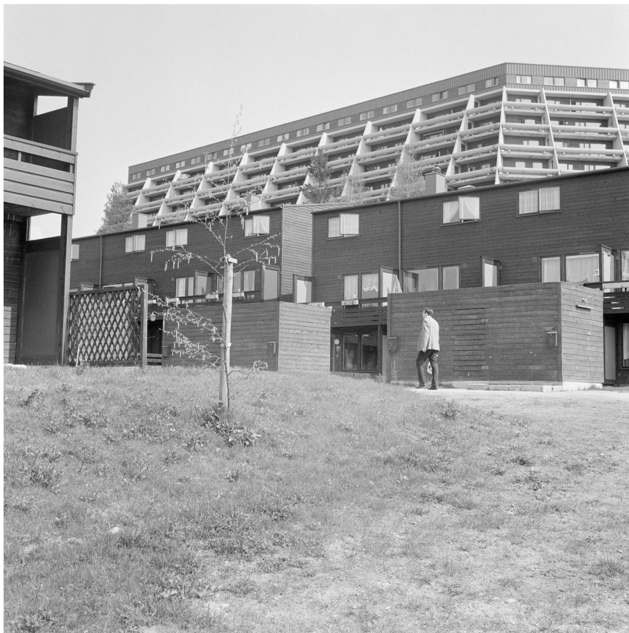
Rekkehus i Jacobine Ryes vei, med terrasseblokker på Tokerudberget i bakgrunnen. Rekkehusene og ikke-bærende vegger i terrasseblokkene ble oppført i bindingsverk med ytterkledning i liggende panel. Foto: Knudsens Fotosenter, 1973. DEXTRA Photo/Norsk Teknisk Museum.
