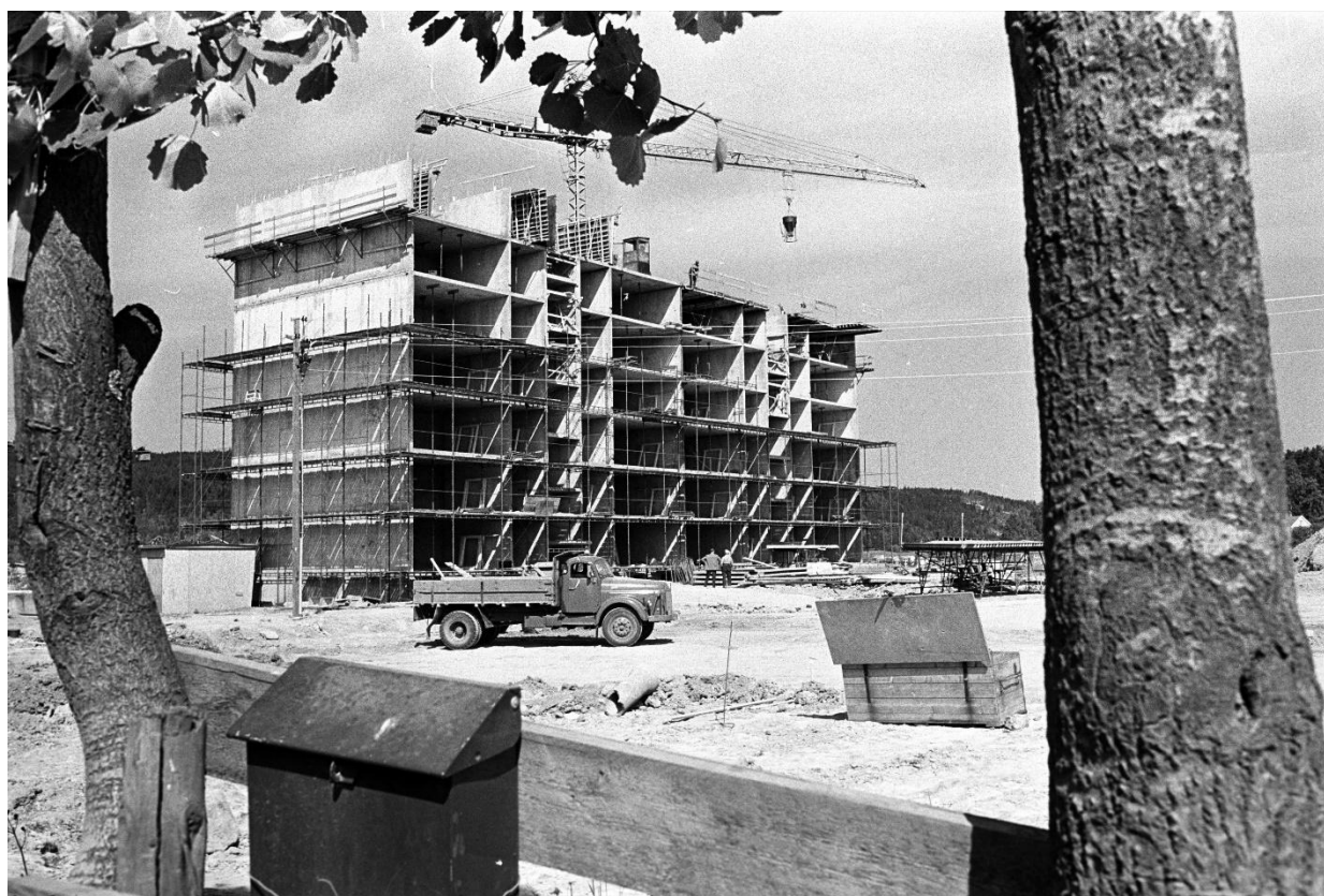
Oppføring av boligblokk på Haugenstua. Blokkene ble oppført med bærende konstruksjoner i plasstøpt betong. Ikke-bærende fasader ble deretter kledd med prefabrikkerte betongelementer. Foto: Dagbladet, 1968. Norsk Folkemuseum.
