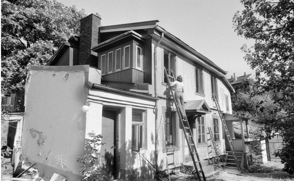
Strømsveien 47 på Vålerenga under oppussing i arkitekturvernåret 1975. Foto: Ukjent, 1975. Arbeiderbevegelsens arkiv og bibliotek.
