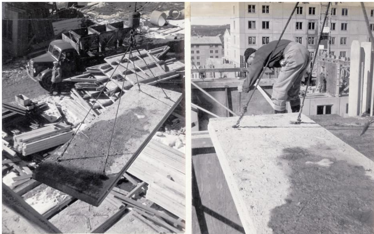
Bygging med prefabrikkerte betongelementer i Tonsenjordet borettslag (Traverveien) på Årvoll i 1954. Foto: Bjørn Winsnes, 1954. Hentet fra Oppdag Groruddalen.
