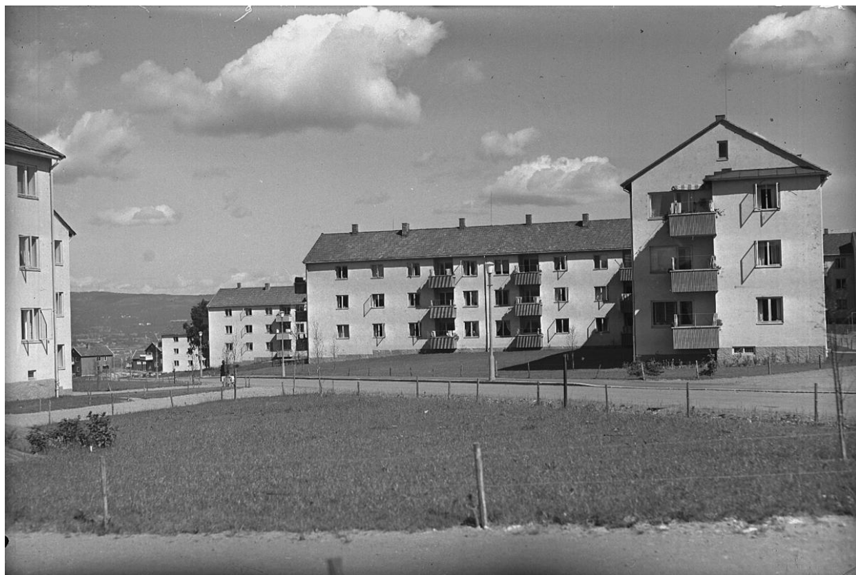
Lille Ekeberg ble bygget på slutten av 1940-tallet. Blokkene i Enoks vei 7-37 er typiske – 3 etasjer, saltak, pusset mur og tofagsvinduer. Blokkene ligger vinkelrett mot hverandre i et sikk-sakk-mønster, som skaper andre typer nabolagsrom enn parallelle lameller. Foto: Wilhelm Råger, 1951. Oslo Museum.
