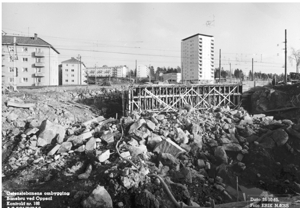
Østsjøbanen fra Etterstad til Bryn ble etablert av AS Akersbanene i 1923 og forlenget til Oppsal allerede i 1926. I 1958 ble Bøler ny endestasjon. På 1960-tallet ble Østsjøbanen ytterligere forlenget til Skullerud og bygget om fra trikk til t-banestandard med strømskinne-system. Den nye T-banestrekningen åpnet i 1967. OBOS-bebyggelse i Haakon Tveters vei og Skøyenåsveien på Oppsal i bakgrunnen på bildet. Foto: Erik Næss, 1965. Oslo byarkiv.
