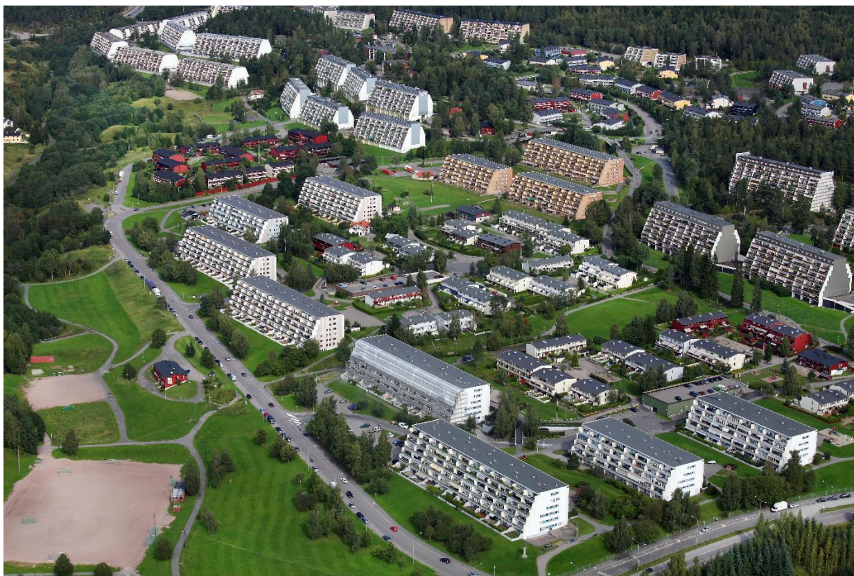
Flyfoto av terrasseblokker og rekkehus på Vestli. Foto: Rune Nylund.
