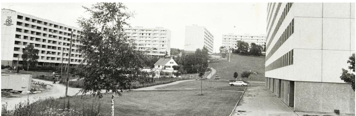
Blokkene på Haugenstua med Stig gård bevart på toppen av det fallende, åpne landskapsrommet som omkranses av blokkene. OBOS-logoen er godt synlig på gavlveggen på blokka lengst til venstre i bildet. Foto: Terje Akerhaug, 1988. Arbeiderbevegelsens arkiv og bibliotek.
