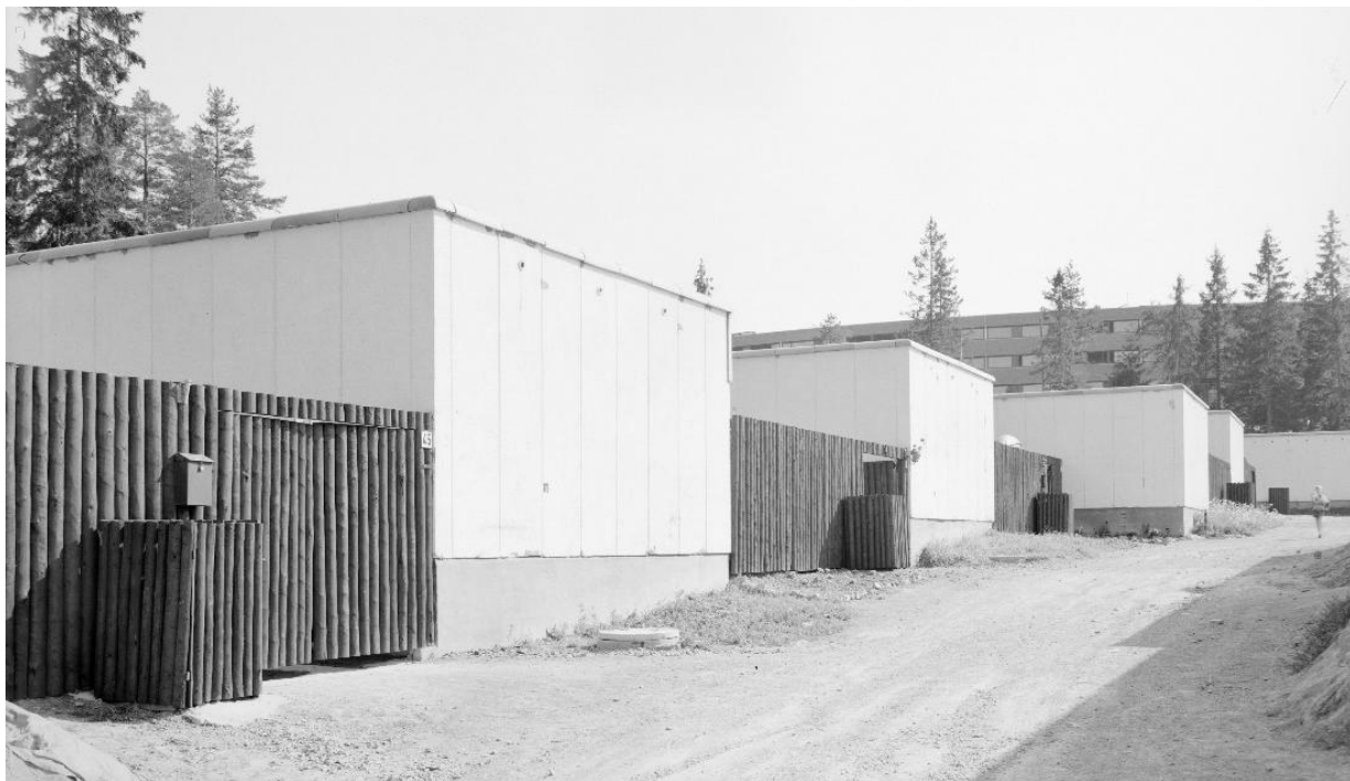
Atriumhusene i Alunsjø borettslag på Ammerud like etter ferdigstillelse. Husene var tegnet av Håkon Mjelva. Foto: Teigens fotoatelier, ca. 1966-72. DEXTRA Photo/Norsk Teknisk Museum.
