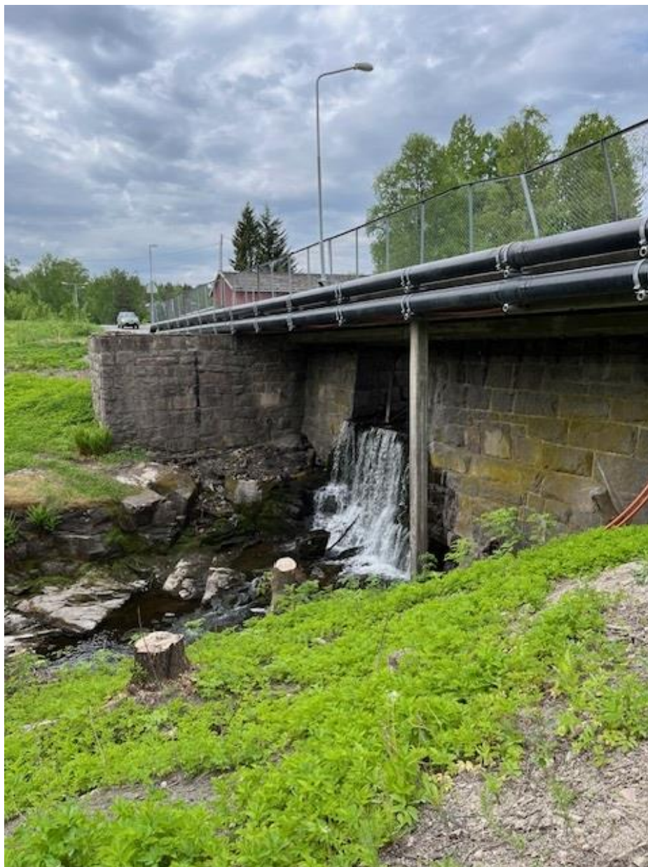
Figur 3-3: Rett nedstrøms Verkensdammen. Videre nedstrøms er elva mer dekket med vegetasjon, med en del gråor og hegg hengende over elveløpet. Foto: Rune Moe.
