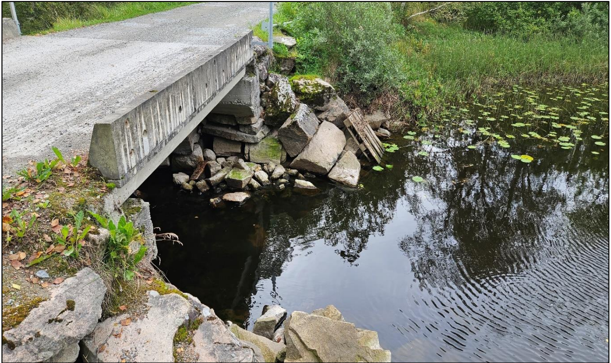
Figur 3-14 Påverudelva ved bro sett oppstrøms 2023
