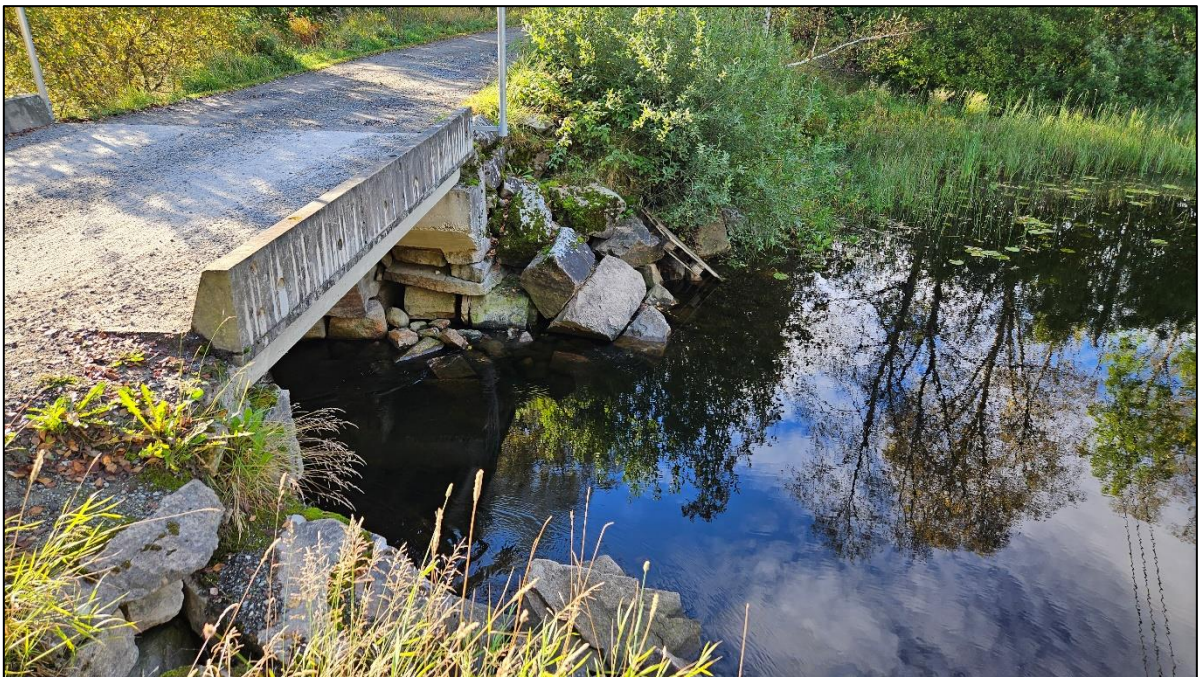
Figur 3-15 Påverudelva ved bro sett oppstrøms 2023
