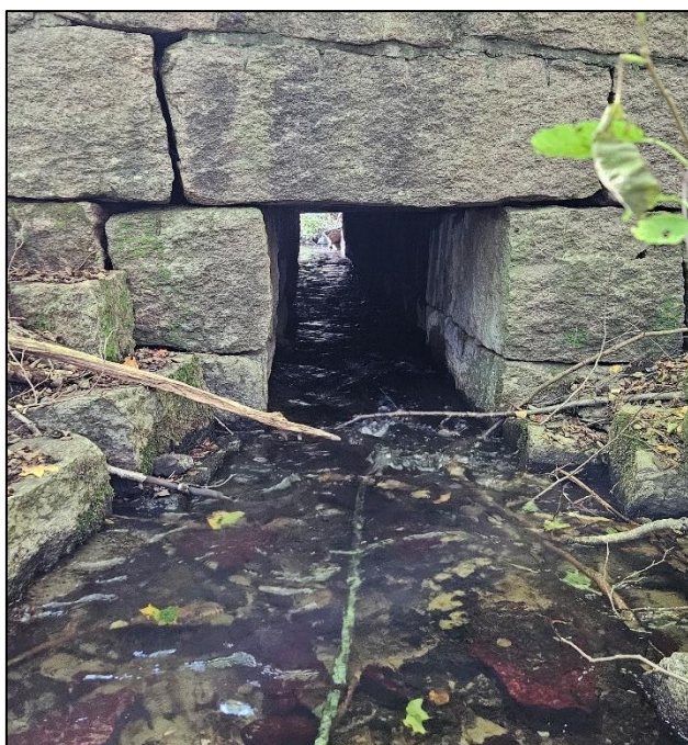
Figur 3-8 Utløpet av oppsjøbekken renner under en steinkistekulvert under Fv.1436 før den renner til Ulvenvannet. Bilde September 2024.
