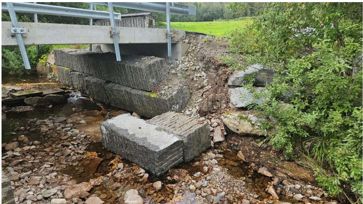
Figur 3-8. Utsklidning av brufundament i bekk.
