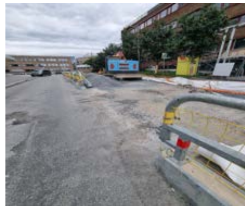
Prosjekt: Rolf Hofmos gate Entreprenør: Agaia AS
