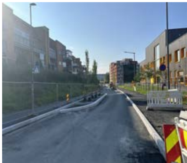
Prosjekt: Lunden Entreprenør: Østlandske Vei og Betong AS
