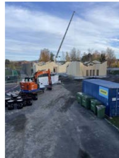
Prosjekt: Kalbakken servicebygg Entreprenør: J.I. Bygg AS
