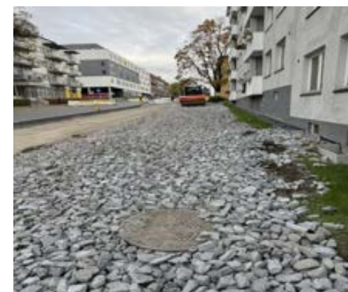
Prosjekt: Sandakerveien Entreprenør: Isachsen anlegg AS
