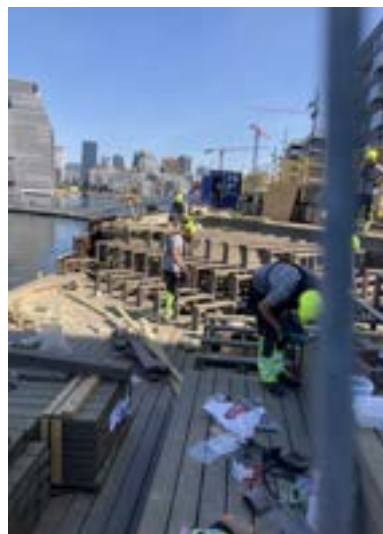
Prosjekt: Sørenga tredekk Entreprenør: JR Anlegg AS
