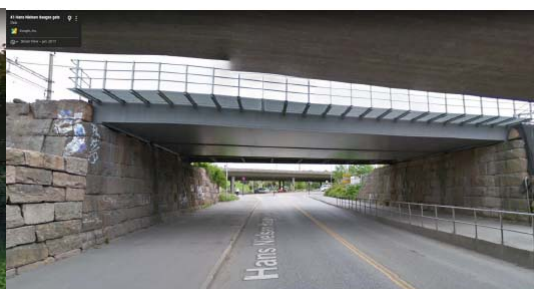
Bru for Gjøvikbanen i Hans Nielsen Hauges gate (ved Sinsen). Bilde: Google Maps
