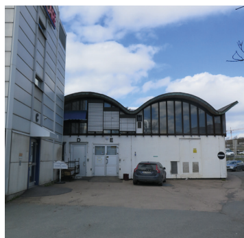
Eksisterende situasjon: Eikenga 31 (Foto: PBE)
