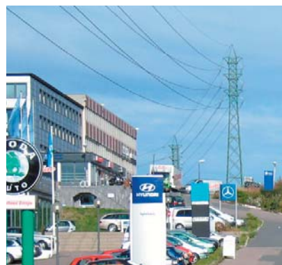
Høyspentledningen langs Ensjøveien graves ned.
