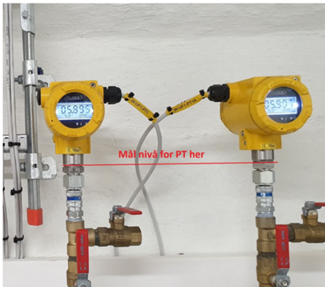
Figur 17: Typiske trykkceller og hvor det skal måles på disse.
