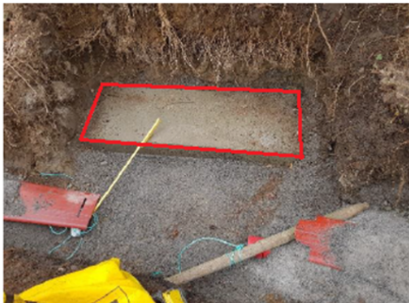
Figur 20: Fundament for skap.
