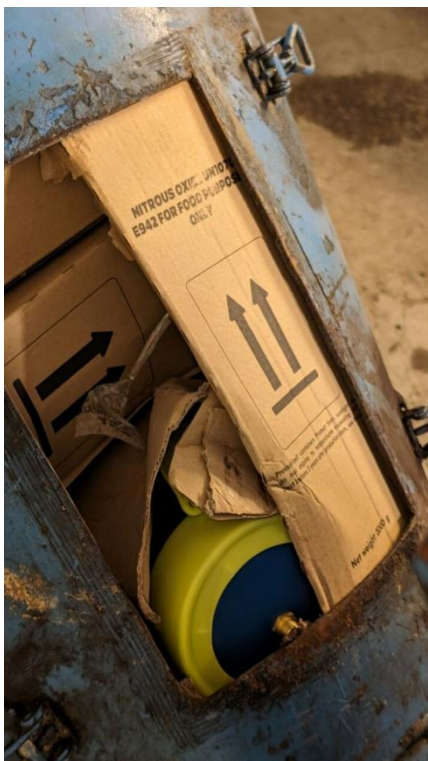
Figur 22 Lystgassbeholder har stoppet til et avfallssug i Oslo
