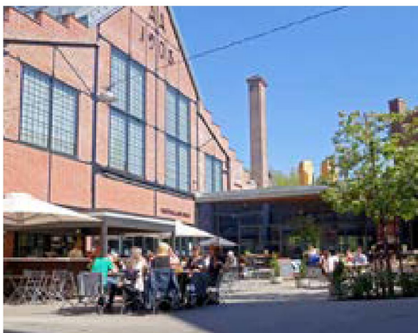
Mathallen på Vulkan, funksjonsendring, omforming og transformering av gammel industrihall (arkitekt: LPO Arkitekter, foto: PBE)
