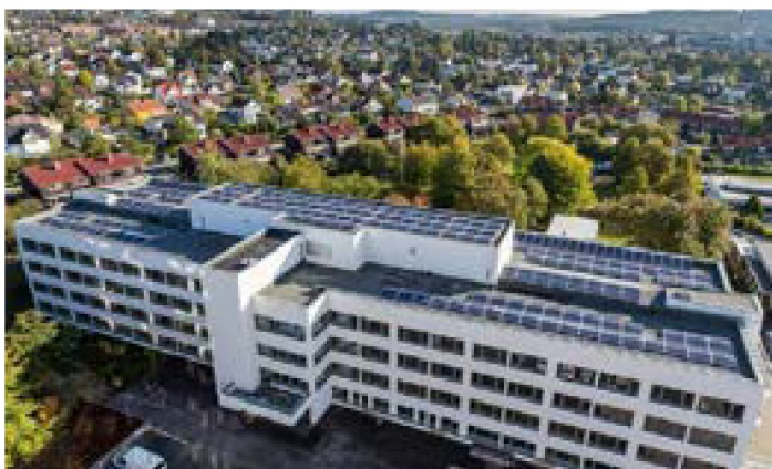
Økern sykehjem har Oslos største solcelletak. Rehabiliteringsprosjektet har redusert energibehovet med 68 prosent sammenlignet med dagens energibehov og 33,5 prosent sammenlignet med et referansebygg etter TEK 10 (FutureBuilt forbildeprosjekt, foto: Tove Lauluten)
