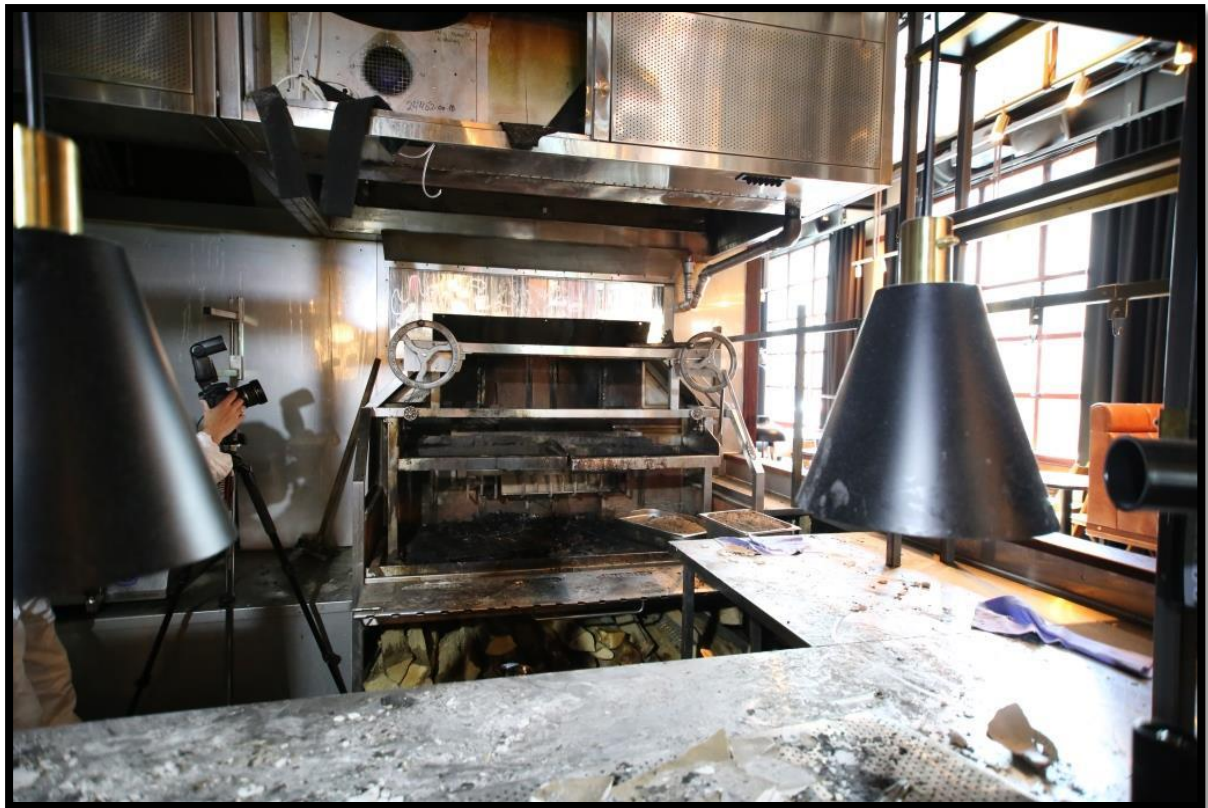
Bilde 4: Grill med tilhørende avtrekkshette, antatt arnested.
