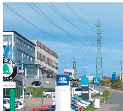
Høyspentledningen langs Ensjøveien graves ned.
