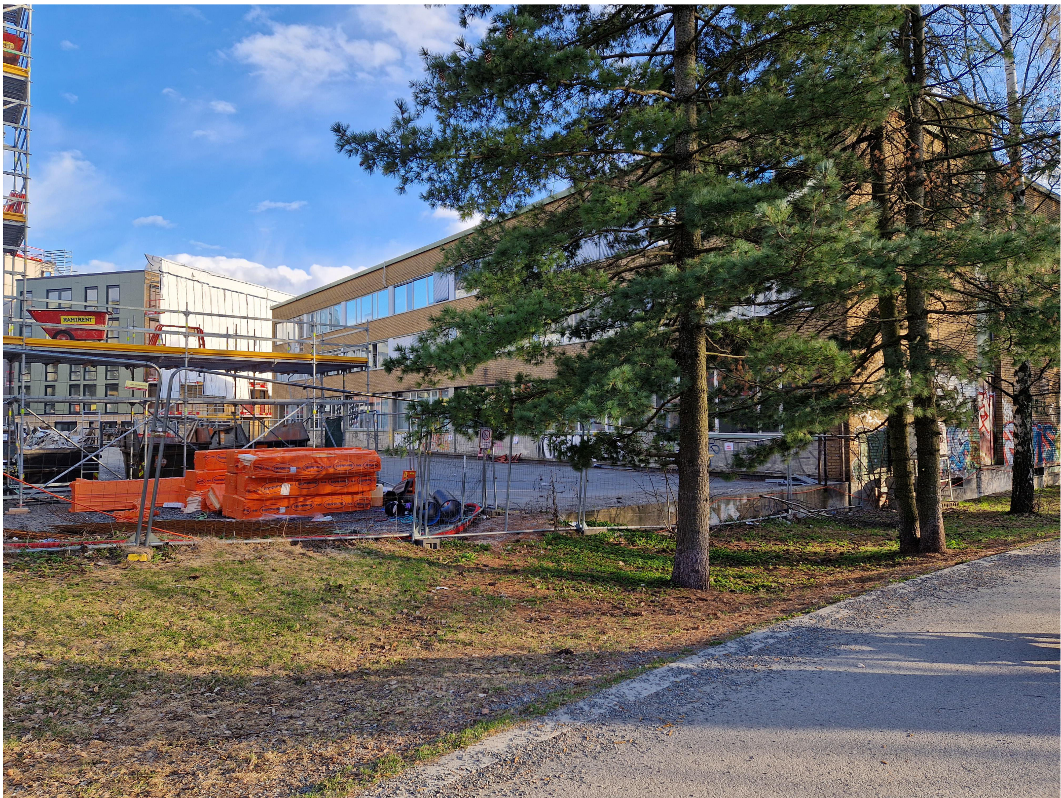
Dagens situasjon - Bilde 29.04.2023
