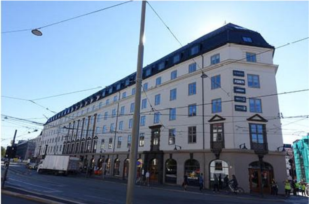
Handelsbygningen, som huset Wehrmachts ingeniørtropper. Oslo Handelsgymnasium ligger rett ned til høyre.
