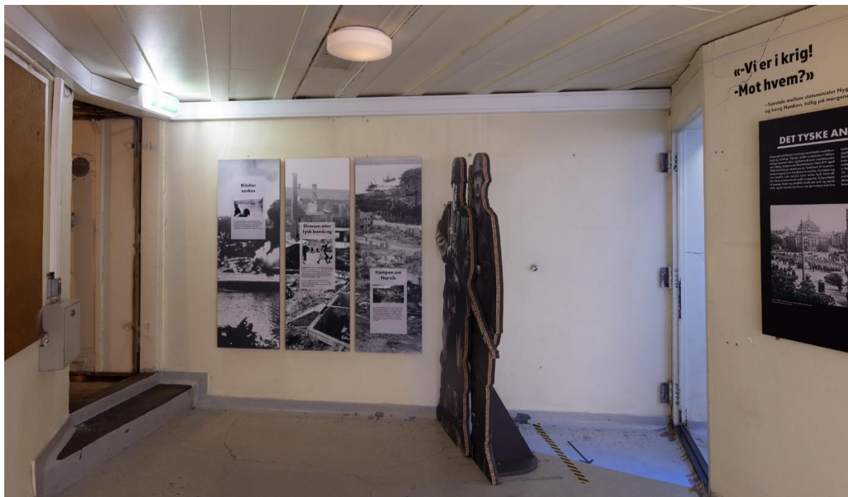
Rom 6. Rommet har en standardutforming som beskrevet innledningsvis. Her er det satt inn en ny lampe i forbindelse med bruksendring og supplerende teknisk utstyr til utstillingen. Til venstre ses ståldøren og inngangen til korridoren som leder inn til skolebygningen og plan 1.
