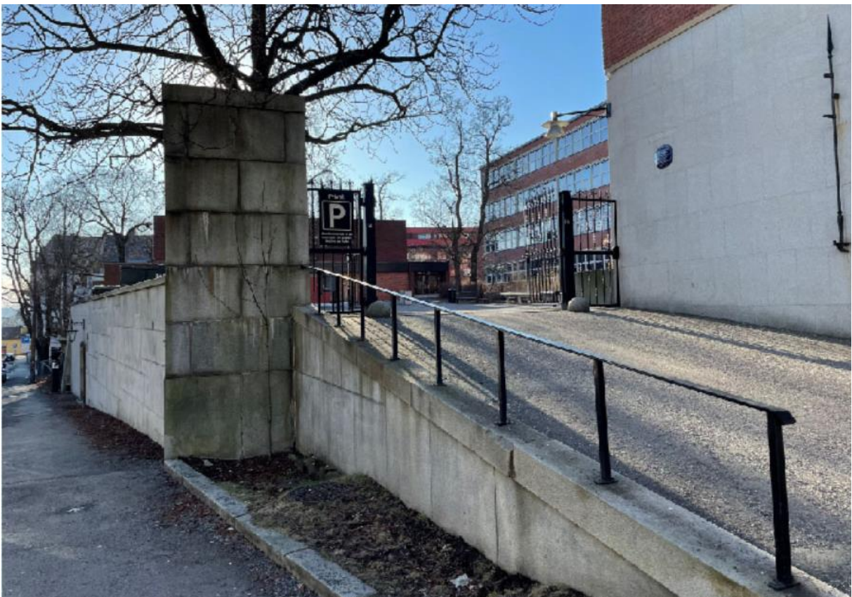
Øverst Parkveien med muren og inngang til bunkeren, nederst skolens hovedadkomst fra Parkveien.
