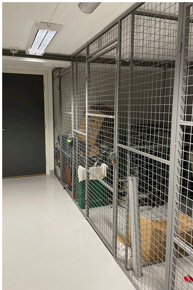
Eksempelbilde på et bodanlegg som ikke anbefales. Veggene bør være tette for å hindre innsyn inn i andres boder for å redusere faren for innbrudd.
