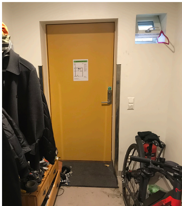
Eksempelbilde på et lite luftevindu ved siden av inngangsdør. Bilde fra befaring.
