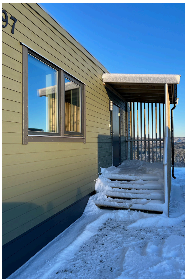
Bilde fra befaring. Bildet viser en boliginngang til et småhus som er dårlig planlagt for universell utformet tilkomst, men er et godt eksempel på overbygget inngangsparti og spilevegg som skjermingstiltak mot naboer.
