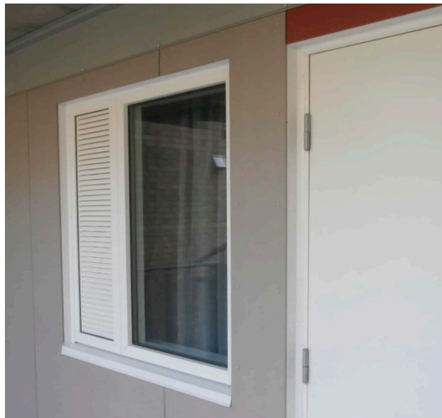
Eksempelbilde på en brannklassifisert lufteluke ved siden av et fastvindu. Kilde: securo.no
