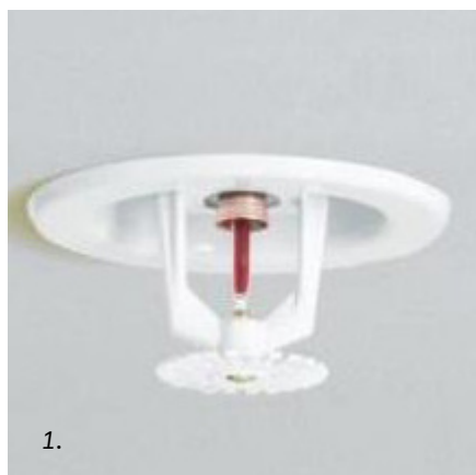
Hengende sprinkelhode - montert i himling Ikke anbefalt
