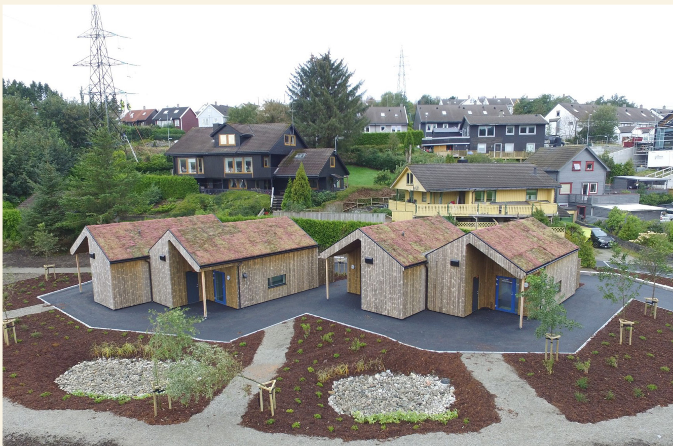
Eksempelbilde fra et prosjekt av et nybygget samlokalisert boliger til personer med rus og psykiske helseproblemer, som har et godt arkitektonisk uttrykk og glir godt inn i nabolaget.
