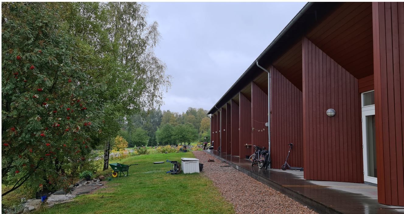
Bilde fra befaring, som viser tilfellet der informant bor i enden av bygget og må trille forbi inngangen (plattingen) til alle andre beboere med rullator/rullestol, fordi beboer ikke har tilgang på rampe rett utenfor sin inngangsdør.
