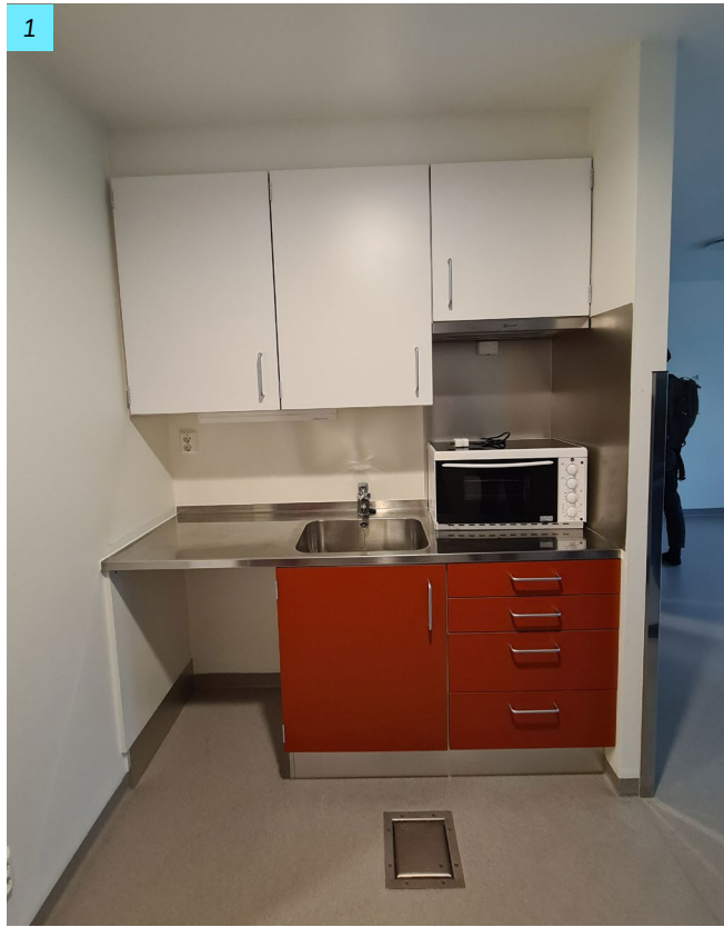
Bilde av samme kjøkken i en ubebodd (1) og bebodd leilighet (2). Det er ikke avsatt plass til vanlig komfyr på kjøkkenet, og plasseringen av hybelkomfyren på benkeplate er både uegnet til matlaging og en direkte brannfarlig løsning, da stikkontakt til hybelkomfyren er rett bak hybelkomfyren. En hybelkomfyr skaper mye ytre varme, og kan potensielt smelte stikkkontakten. Det å bruke en stekepanne over normal benkehøyde er også uegnet ergonomisk. Bilde 2 viser hvordan en beboer anvender samme kjøkken. Med en mikro på benkeplaten er det ikke benkeplass igjen til matlaging. Synlig sluk kan virke stigmatiserende.
