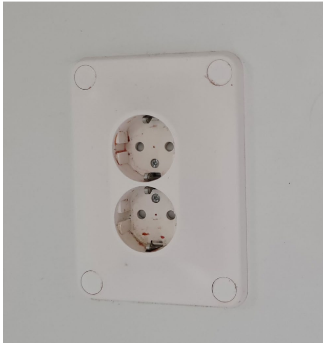
Bilder fra befaringer. Bildet til venstre viser en vandalsikker stikkontakt og bildet til høyre en vanlig stikkontakt som er forsterket i et kjøkkenskap. Løsningen til venstre er å foretrekke.
