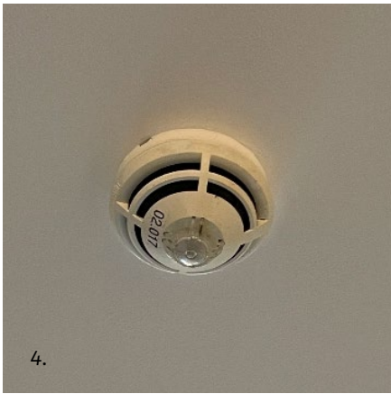
4. Detektor - montert i himling Ikke anbefalt
