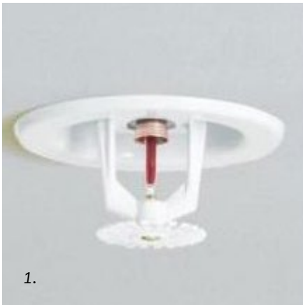
1. Hengende sprinkelhode - montert i himling Ikke anbefalt
