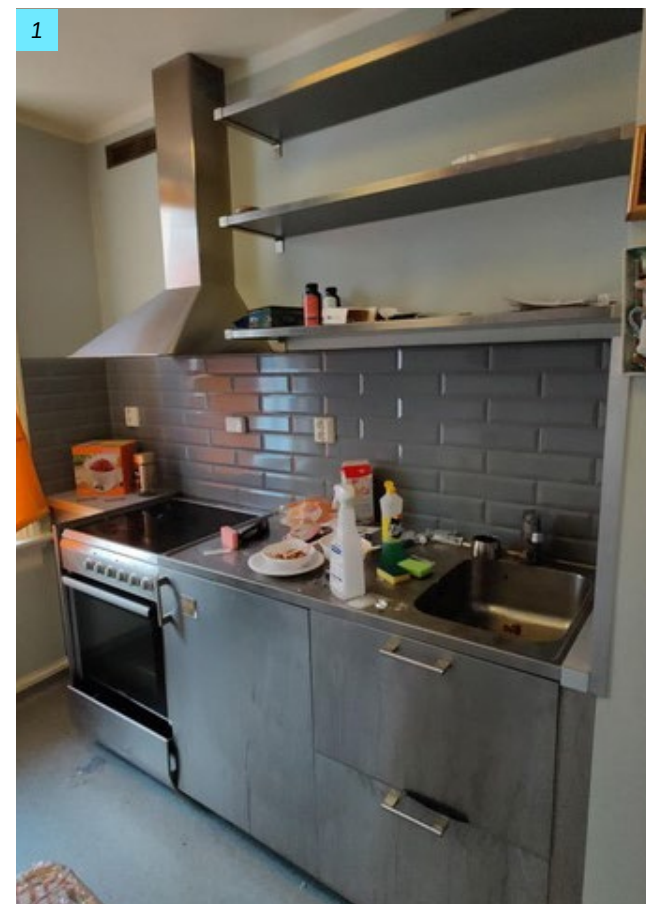
1. Kjøkkenet har primært et inventar av stål (underskap, benkeplate, hyller og kjøkkenvifte), men i kombinasjon med fliser på spruteområdet over benkeplaten gir det likevel et mer hjemlig- enn institusjons uttrykk.
