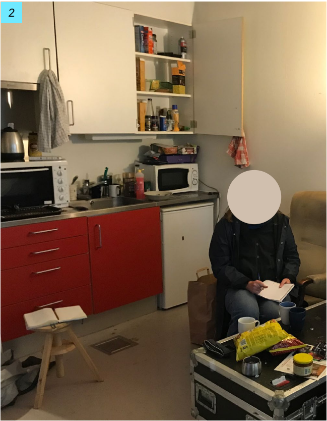
Bilde av samme kjøkken i en ubebodd (1) og bebodd leilighet (2). Det er ikke avsatt plass til vanlig komfyr på kjøkkenet, og plasseringen av hybelkomfyren på benkeplate er både uegnet til matlaging og en direkte brannfarlig løsning, da stikkontakt til hybelkomfyren er rett bak hybelkomfyren. En hybelkomfyr skaper mye ytre varme, og kan potensielt smelte stikkkontakten. Det å bruke en stekepanne over normal benkehøyde er også uegnet ergonomisk. Bilde 2 viser hvordan en beboer anvender samme kjøkken. Med en mikro på benkeplaten er det ikke benkeplass igjen til matlaging. Synlig sluk kan virke stigmatiserende.
