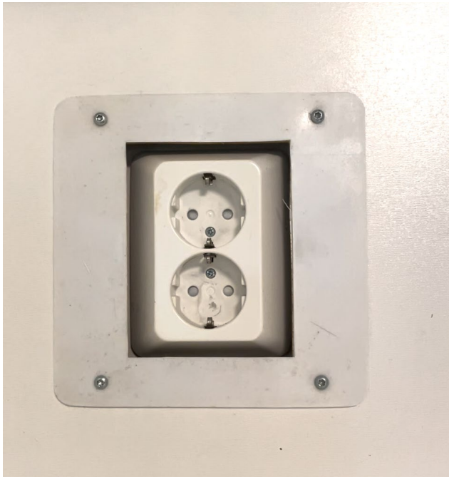
Bilder fra befaringer. Bildet til venstre viser en vandalsikker stikkontakt og bildet til høyre en vanlig stikkontakt som er forsterket i et kjøkkenskap. Løsningen til venstre er å foretrekke.
