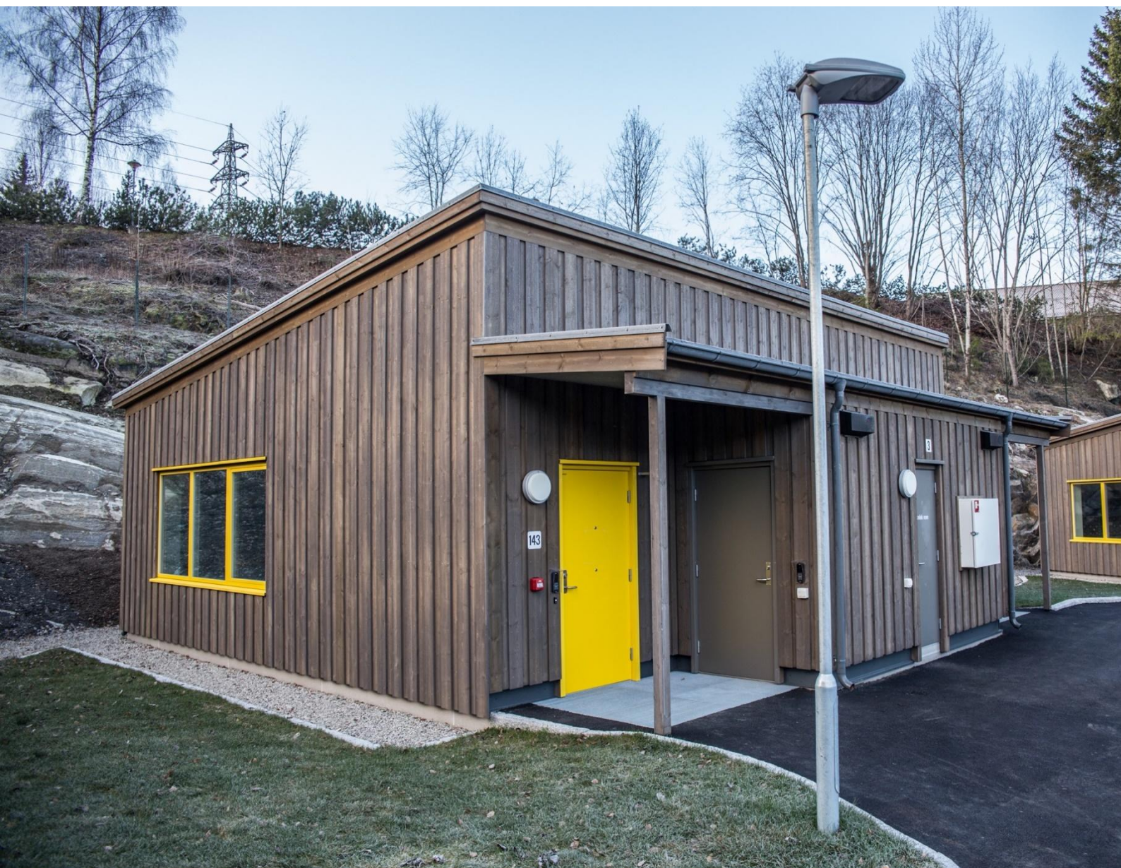
Ljabruveien boliger. Foto: Velferdsetaten
