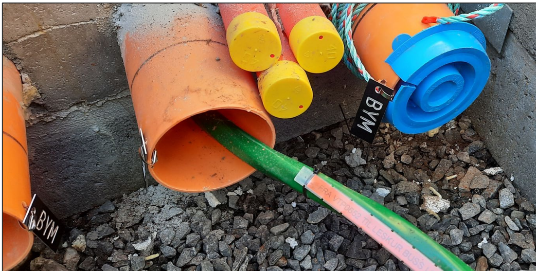
Figur 5-4: Eksempel på merking av rør i kum.
