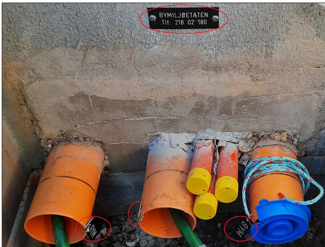
Figur 5-9: Eksempel på merking av trekkekum.
