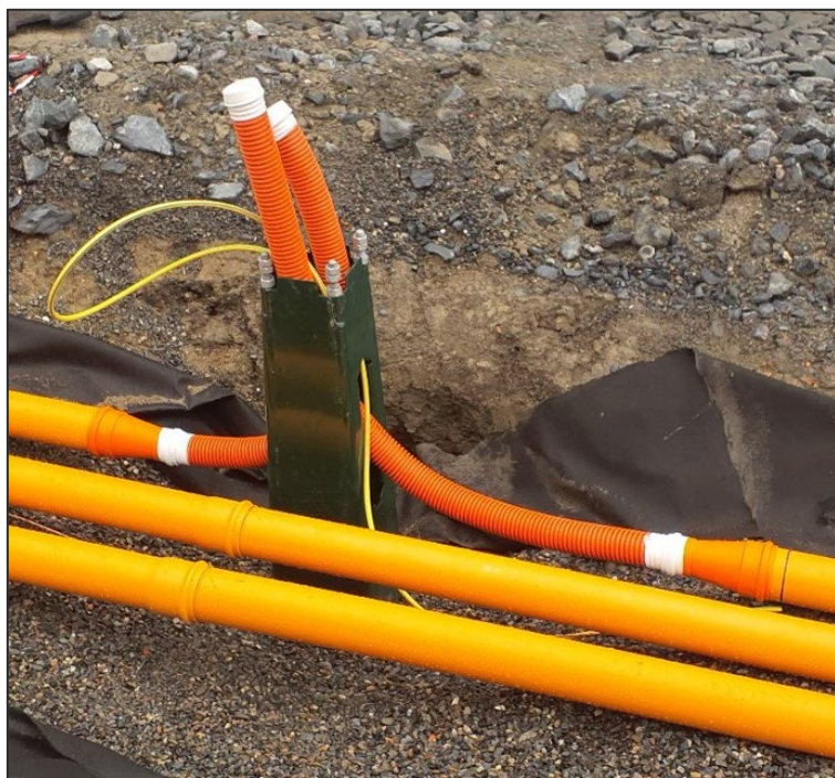
Figur 5-3: Eksempel på bruk av DV-rør og overgangsmuffe.
