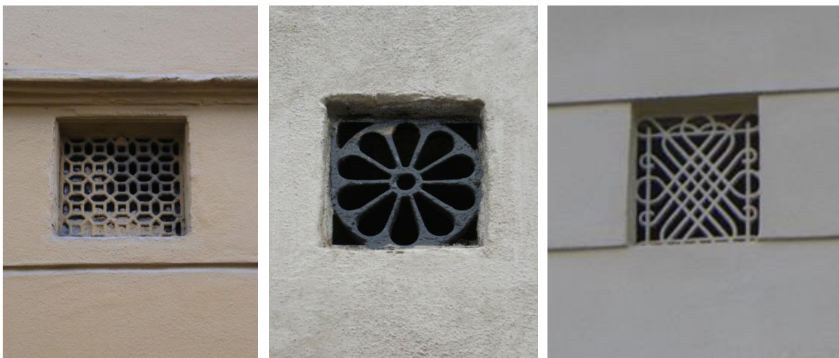
Eksempler på forseggjorte gamle ventilasjonsrister. Foto: BYA v/ Cathrine Reusch og Bengt Lifoss.
