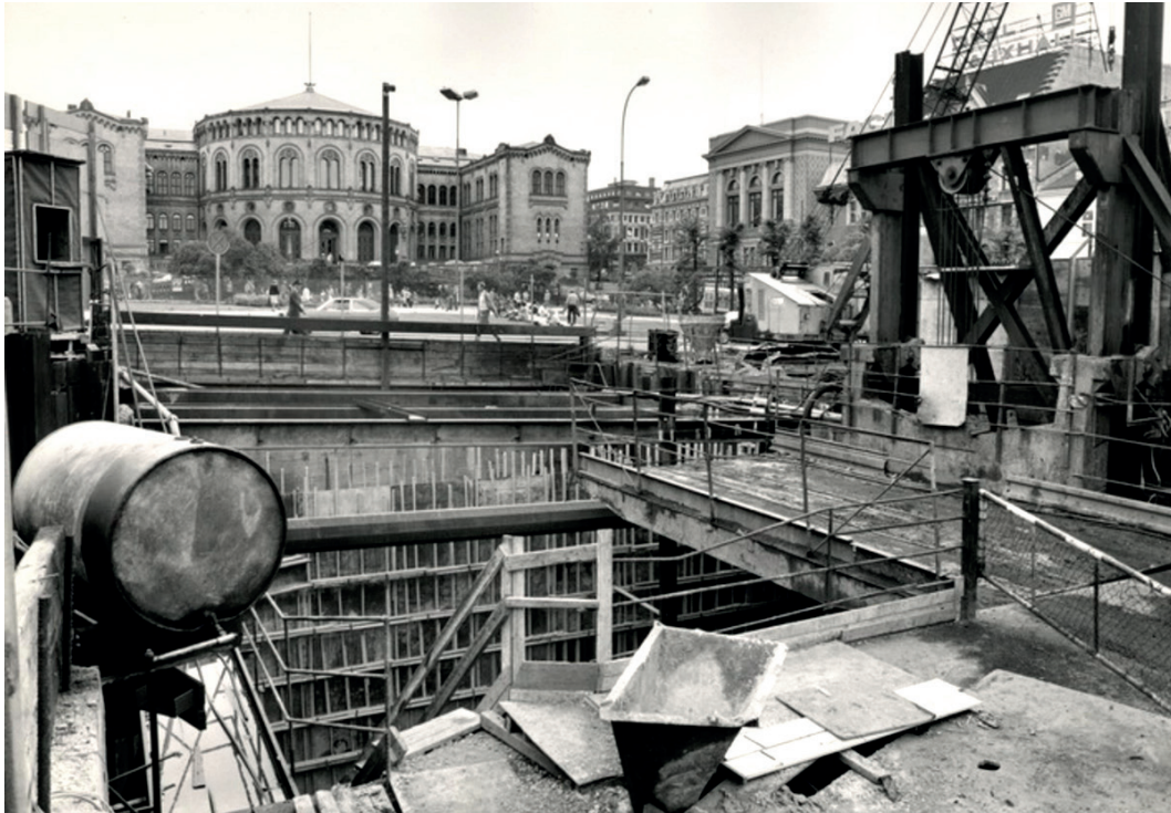
Arbeider under bakken ved Stortinget i Oslo. (foto Oslo kommune)
