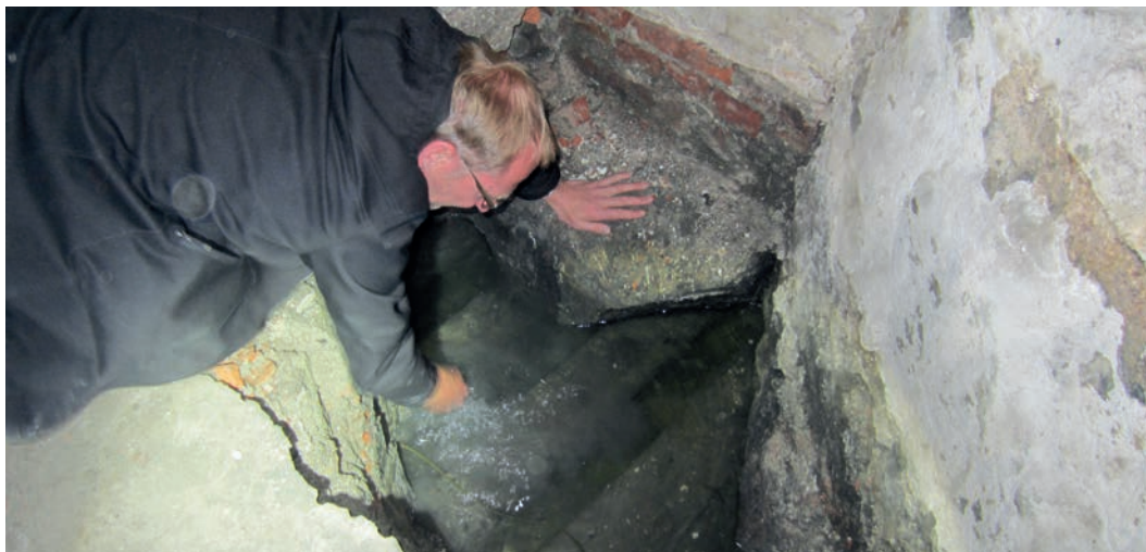
Grunnvann rundt fundamenter i murgårdsbebyggelse i Oslo
