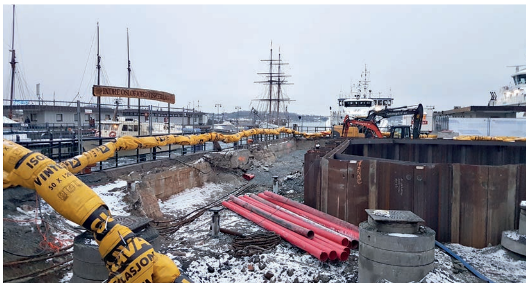
Utbygging av infrastruktur under bakken ved sjøkanten i Oslo. Foto/PBE
