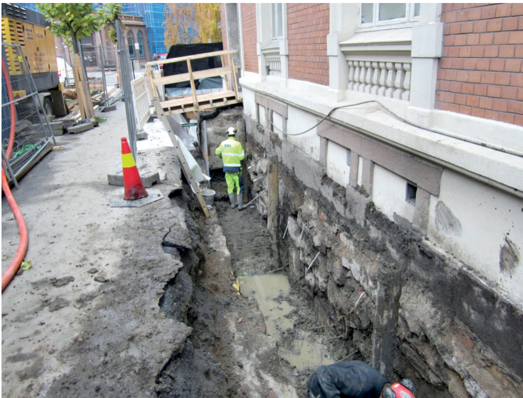
Refundamentering av murgårdsbygging i Oslo. (Foto: Multikonsult)
