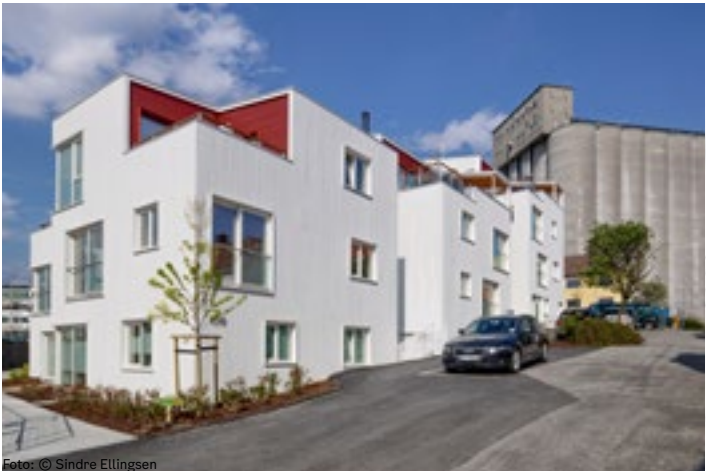
Over: Bebyggelsen sett fra gatenivå. Fasaden er brutt opp i mindre volumer for å tilpasse seg småhusbebyggelsen i området rundt.
