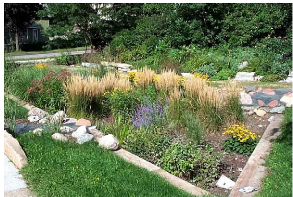
Fig. 6.17 Eksempel på regnbed - vanninfiltrasjon.
