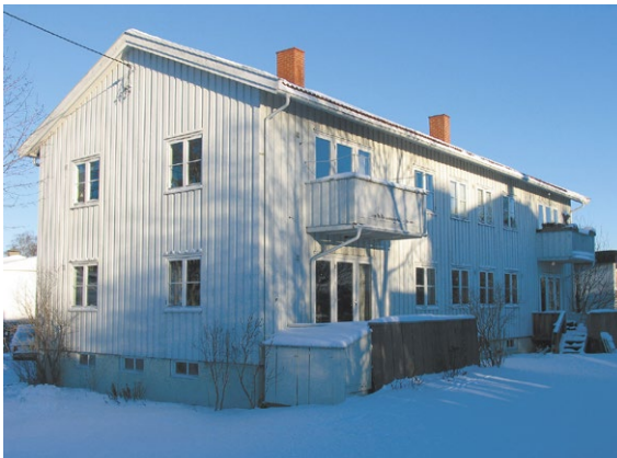
Fig. 3.19 Lavblokk med småhuskarakter i Diakonveien.
