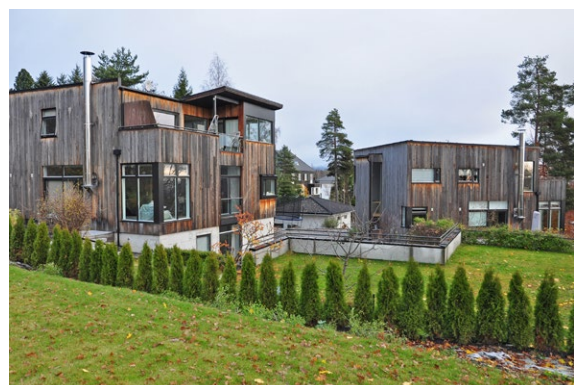
Fig. 3.4 Bebyggelse i gruppe med småhuskarakter, Brantenborgveien.
