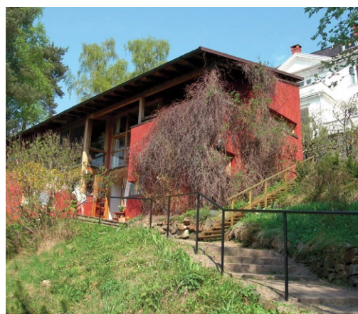
Fig.6.13 Bolig med flere etasjenivåer med god tilpasning til terreng - boligen følger terrenget.
