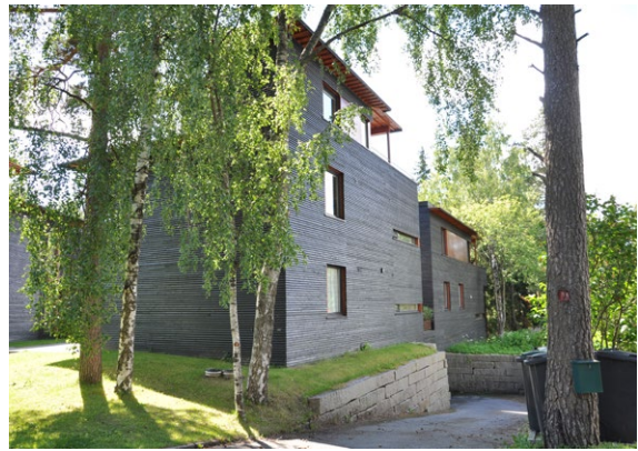
Fig. 6.15 Terrengtilpasset nedkjørsel til garasje med lav forstøtningsmur.
