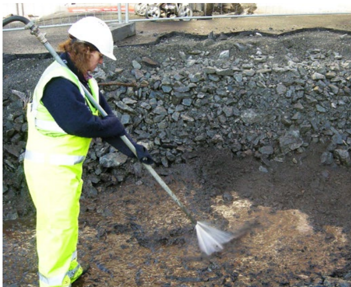
Figur 10 viser utlegging og komprimering av sprengstein, beskyttelse av belysningskabler med rothindrende separasjonsduk og nedspyling av vekstjord, Foto: Erik Solfeld.
