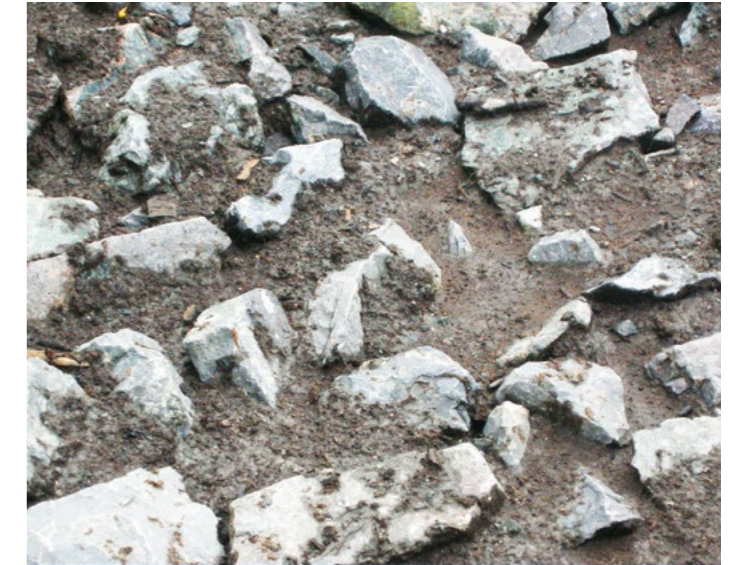
Figur 11 viser et jordmettet lag med sprengstein, geotekstil mellom luftig bærelag og asfalt, samt ferdig resultat av treplanting i Finnmarksgata på Carl Berner.
