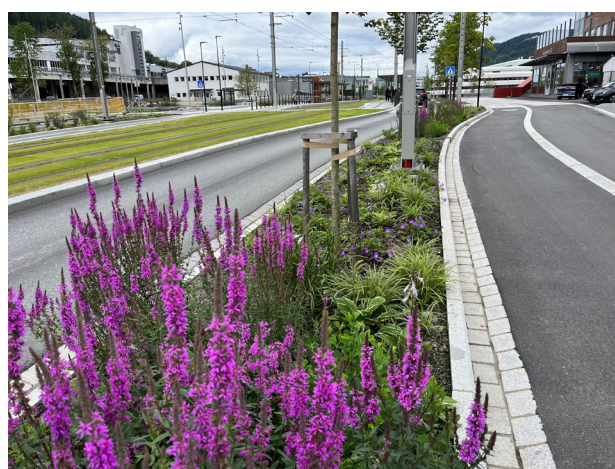
Bilde 1: Renner som samler vannet og fører det til regnbedene reduserer problemer med sprut fra gata. Eksempel fra Kanalvegen i Bergen.
