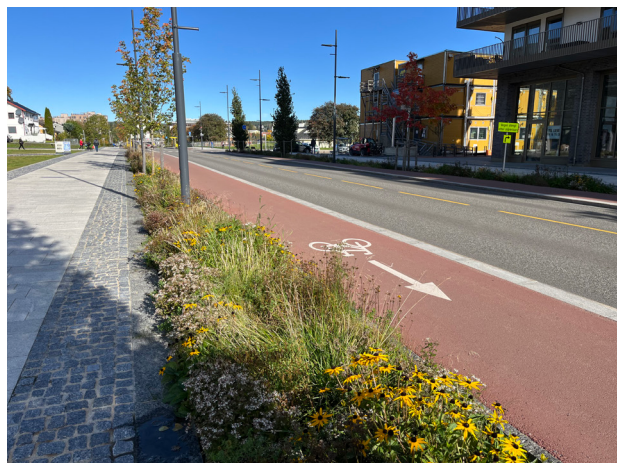
Bilde 3: Sykkelfelt mellom kjøreareal og regnbed gir større avstand og dermed mindre påvirkning fra vegen. Eksempel fra Skårersletta i Lørenskog.
