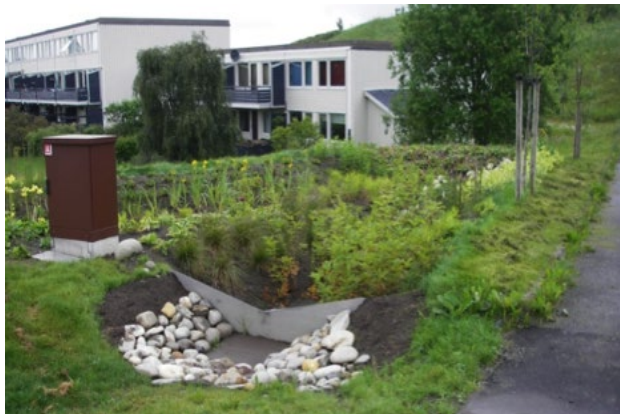
RIS har et lite sedimentasjonskammer ved innløpet for å lette vedlikeholdet av regnbedet (foto: Arvid Ekle).
