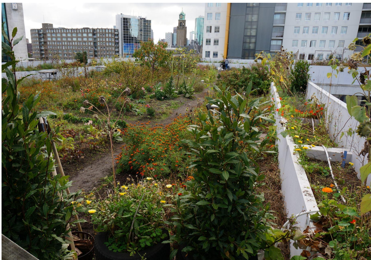
Figur 46. Taket er på 1000 m 2 og ble ferdigstilt i 2012. Siden taket har lav bæreevne er vekstmediet tynt og lett. I sesongen selges bl.a. spiselige blomster til restauranter i nærmiljøet hver fredag. De leveres samme dag som de plukkes. For øvrig dyrkes grønnsaker og fiken (fig. 44; midtbildet).
