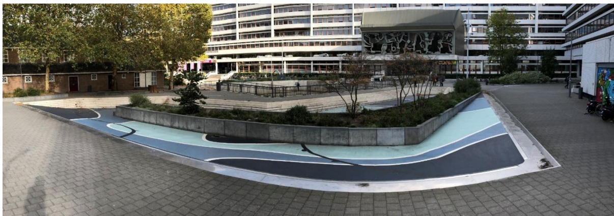
Figur 34. «Vannplassen» samler takvann fra byggene i nærheten, samt fra oppholdsarealet på gateplan. De første mm av nedbøren («first flush») blir sendt til rensenanlegget. Ved 10 mm over 2 timer begynner anlegget å fylles. Dette skjer flere ganger per år.
