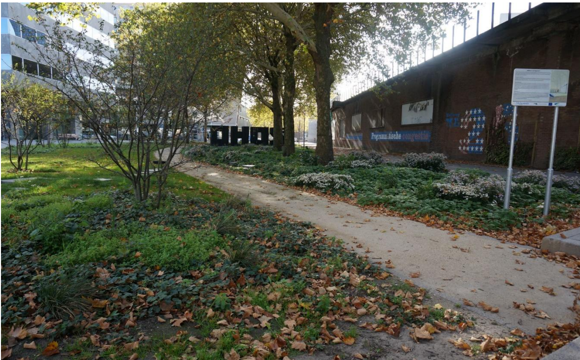
Figur 40. ZOHO regnbed med trær, gangvei, areal for oversvømmelse og informasjonsskilt. Den nedlagte jernbanen, Hofbogen, sees til høyre.
