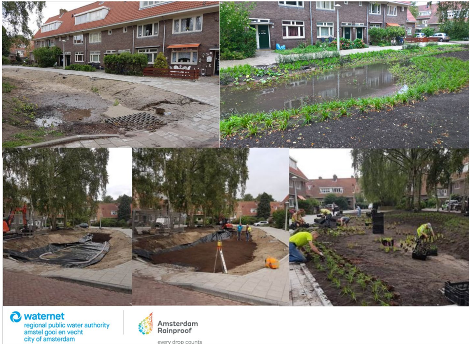
Figur 17. I 2017 ble et regnbed anlagt ved å skifte ut jordmasser med sandig jord og beplantet (fra Goedbloed's presentasjon).
