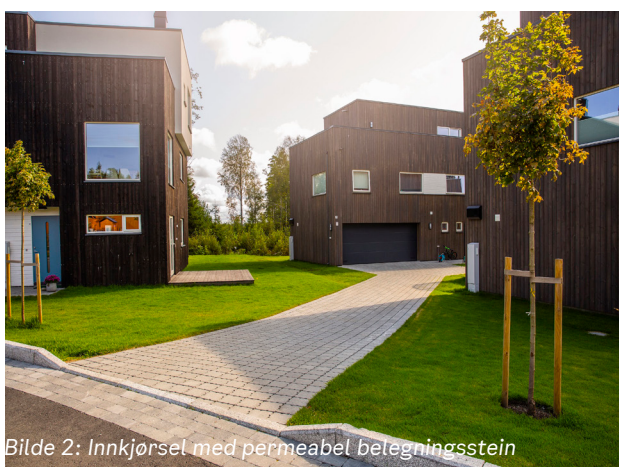
Figur 2: Vannet renses/filtreres naturlig på vei gjennom konstruksjonen. Partikkelbundet forurensning reduseres betydelig og organiske stoffer brytes ned.
