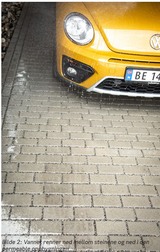
Bilde 3: Vannet renner ned mellom steinene og ned i den permeable oppbygningen
