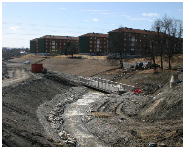
Bilde fra byggeplass under anlegging av Hovinbakkens løp gjennom Bjerkedalen park. Foto: Rainer Stange
