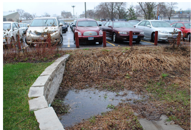
Regnbed som fanger opp avrenning fra parkeringsplass ved University of Minnesota, St.Paul, USA. Vannet infiltrerer ned til grunnen mens forurensningen forblir i filtermediet.
