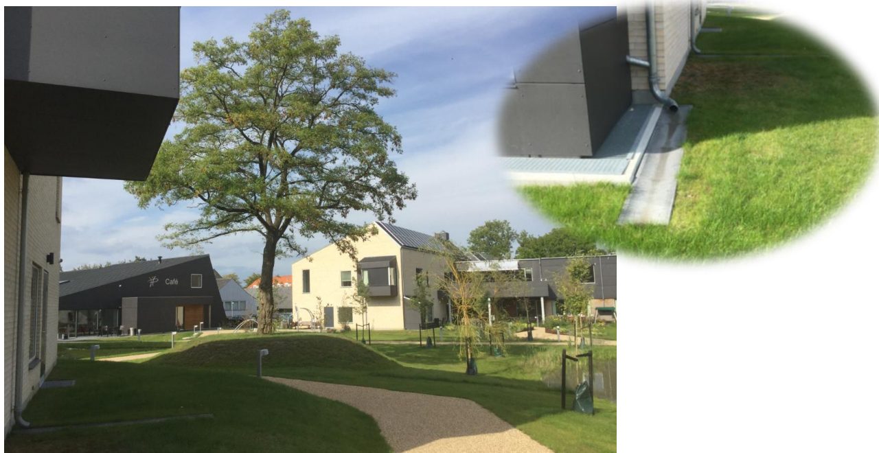
Figur 53. Holmegårdsparken har flere lavbygg, med grusganger imellom. Grusgangene er tilpasset bruk av gåstoler. Alle taknedløp har utkast til terreng, på overflaten eller i renner.
