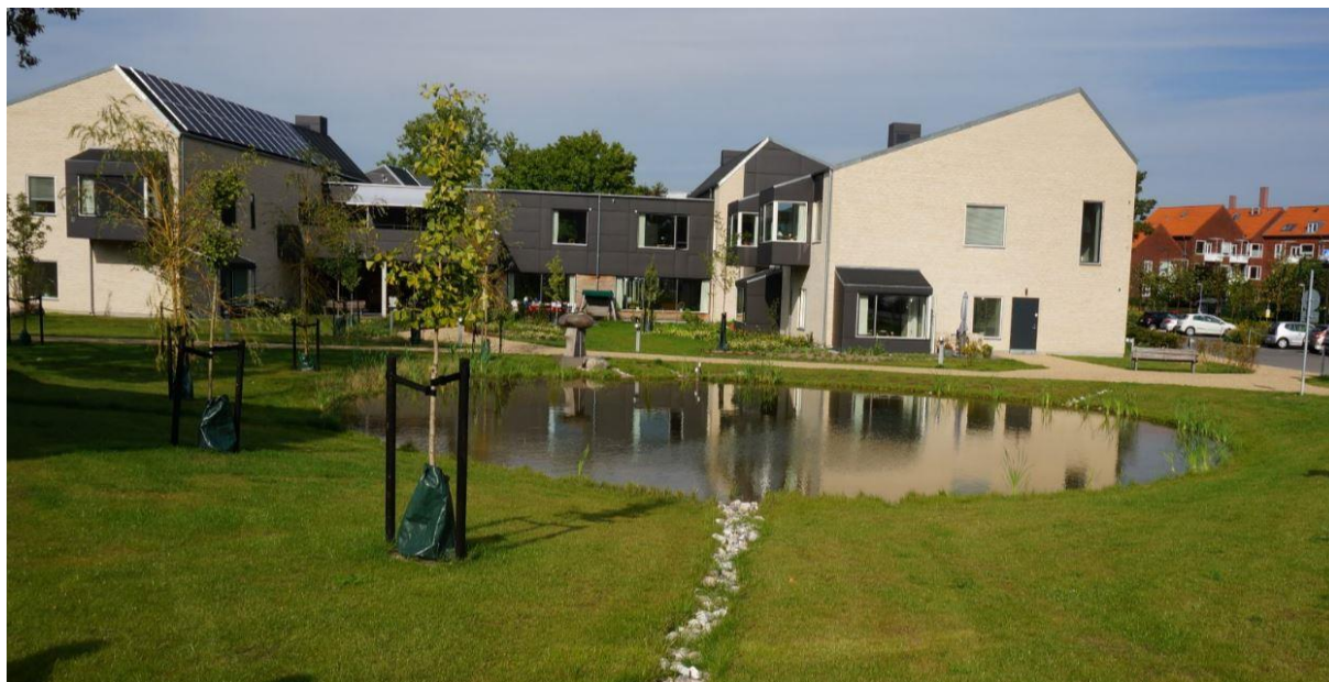
Figur 56. Dammen mottar overvann fra øvrige overvannstiltak.
