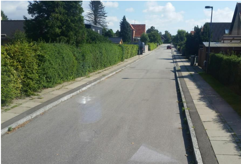
Figur 37. I denne gaten har slukene blitt tettet og kantsteinen hevet til 15 cm. Overvannet separeres fra avløpsnettet.
