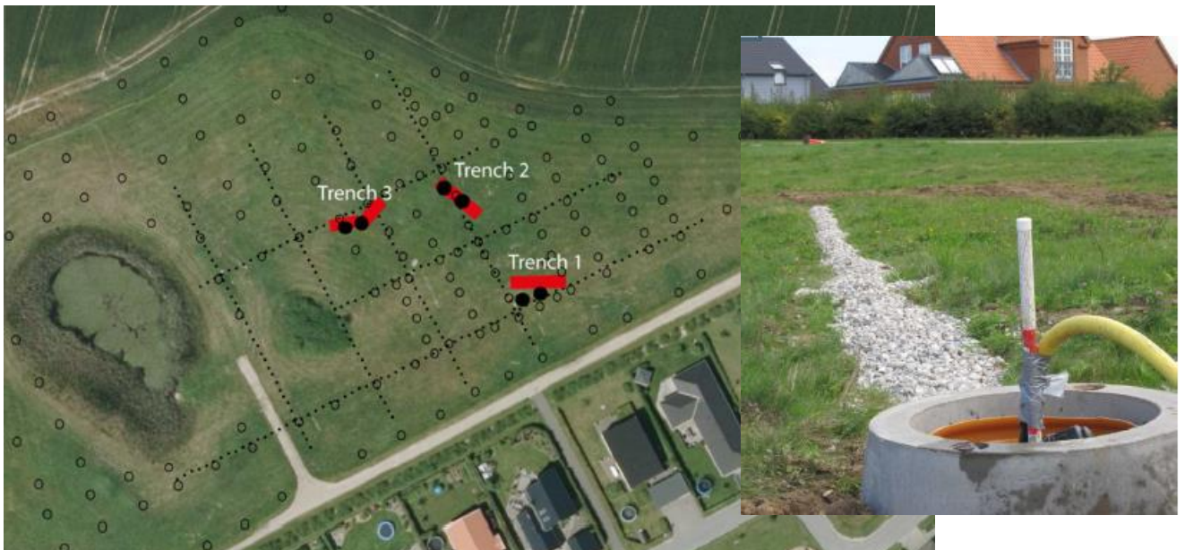
Figur 5. Infiltrasjonsgrøfter plasseres der betingelsene er optimale, basert på undersøkelsene i fig. 4. Tre jordtyper ble undersøkt, og resultatene viste at infiltrasjonen ( K_{sat} ) ved hjelp av renner var betydelig høyere enn målt med punktvis infiltrasjonsmåling (pkt 3 over). Grusfylte infiltrasjonsrenner får best kontakt med områder med god infiltrasjon, og utnytter utsiving i toppjorden hvor porevolumet ofte er høyt (slide fra Marina).
