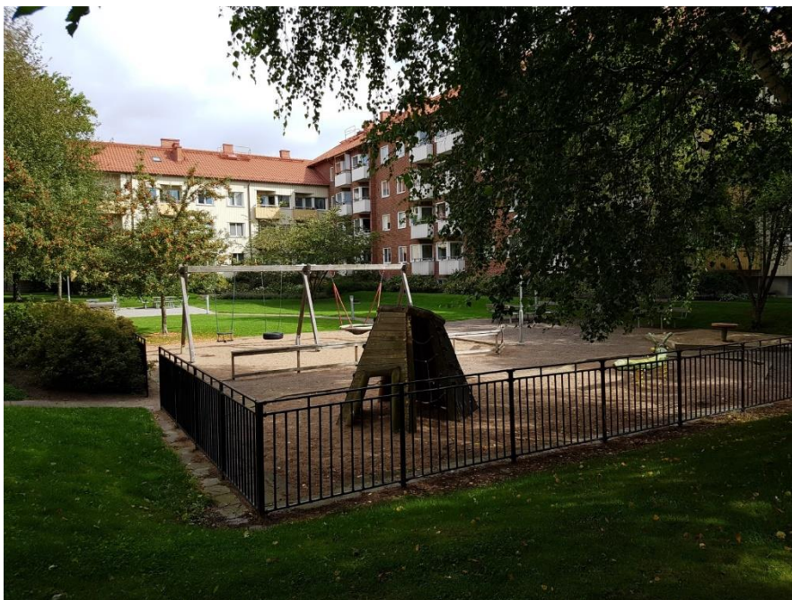
Figur 82. Lekeplass som kan stå midlertidig oversvømt ved skybrudd. Overvannet som holdes tilbake vil dempe avrenningen.
