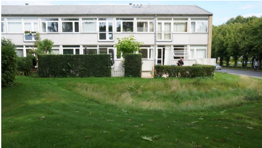
Figur 57. Kommunens tilbud om belønning for frakobling var interessant for beboerne, fordi tiltakene kunne gjøres veldig enkle og rimelige, som å anlegge en fordypning i friarealet som mottok takvannet.
