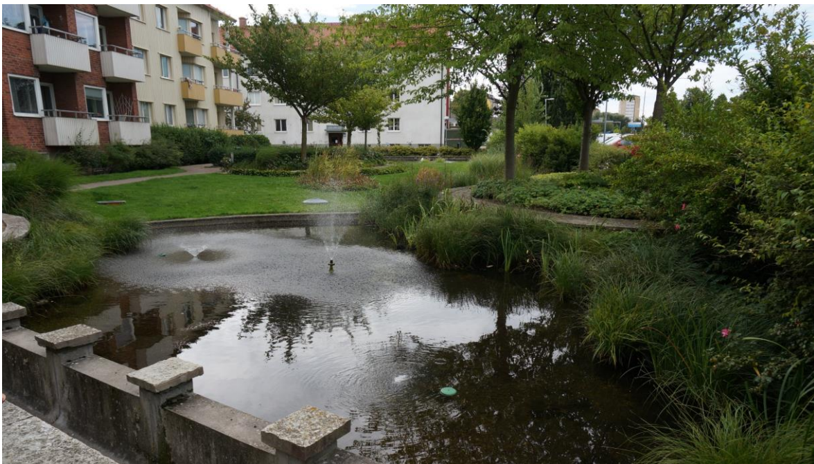
Figur 81. Arealet mellom dammen i fig. 80, som ligger i bildets bakkant, og dammen på bildet er tilrettelagt for midlertidig neddemming. Når arealet er fullt, renner vannet over kanten til betongrenna i forkant av bildet.
