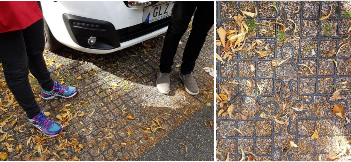
Figur 72. Asfalten på P-plass er skiftet ut med armert grus for å sørge for at lindetrærne får nok vann.
