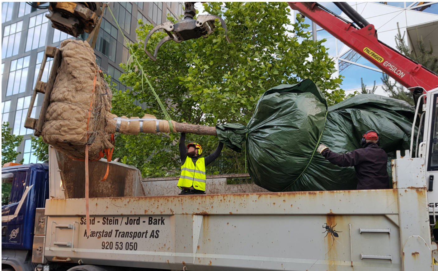
Bilde 3 viser flytting av et tre i forbindelse med ombyggingen av Dronning Eufemias gate. Tre-kronen er pakket inn i plast for å forhindre uttørring under transport. Rotklumpen er godt pakket inn med strie. Trær skal ikke løftes etter stammen, og all vekt må fordeles på rotklumpen. I tilfellet ovenfor hvilte for mye av vekten på stammen under løftet, (Foto: Olve Lundetræ).
