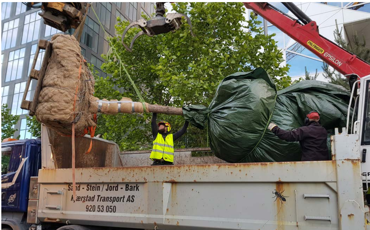
Bilde 3 viser flytting av et tre i forbindelse med ombyggingen av Dronning Eufemias gate. Tre-kronen er pakket inn i plast for å forhindre uttørring under transport. Rotklumpen er godt pakket inn med strie. Trær skal ikke løftes etter stammen, og all vekt må fordeles på rotklumpen. I tilfellet ovenfor hvilte for mye av vekten på stammen under løftet, (Foto: Olve Lundetræ).
