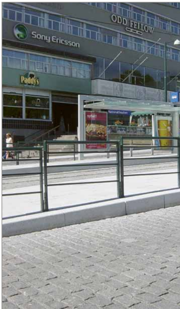
Fig. 85. Nye trafikkrekkverk med vertikalavslutninger i flatjærn og horisontale rundspiler som følger kjøretretningen.
