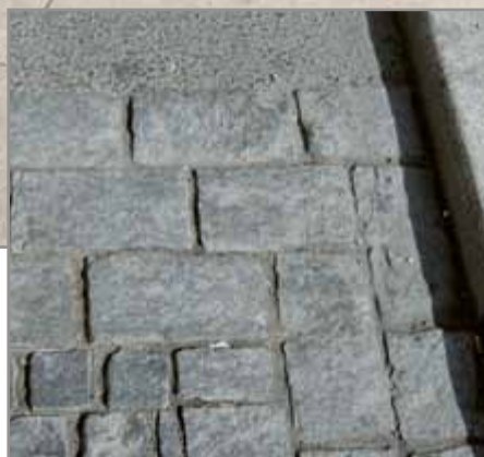
Fig. 37. Fletting mellom gatestein i møte mellom rennesteinskantinger (se Fig. 33).
