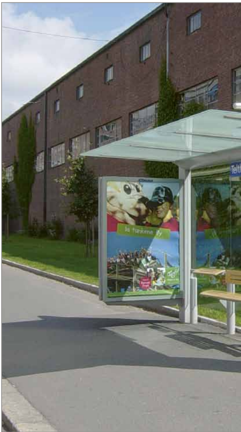
Fig. 80. Det nye leskuret i transparent og lett design med glass, skivekonstruksjoner og i lysegrå farge, oppløser formen mot omgivelsene. Fra Maridalsveien.
