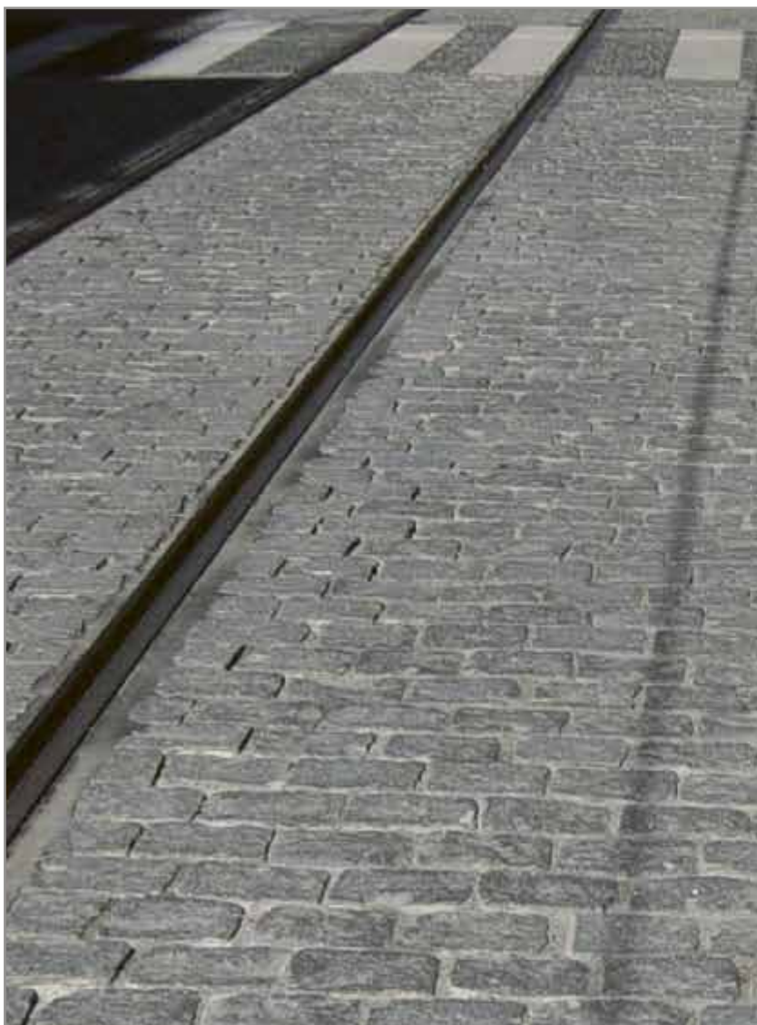
Fig. 29. Natursteinsgate med trikkespor. Fra Stortingsgaten.
