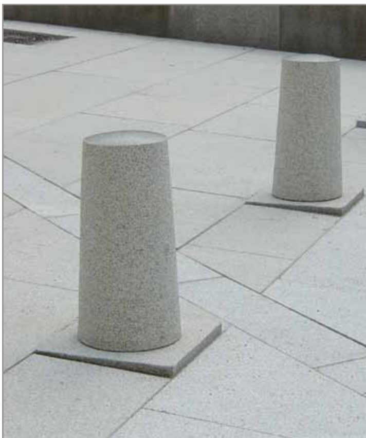
Fig. 89. Nye pullerter i stein med bunnplate, konisk hovedform og polert segmenttopp.
