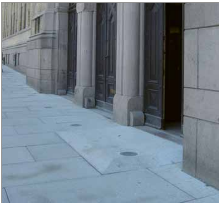
Fig. 39. "Teppe" som hellerampe tilpasset rullestol, enten som en utvidelse av veggkanten eller som en utvidelse av granittfortauet. Fra Stortingsbygningens nordinngang.
