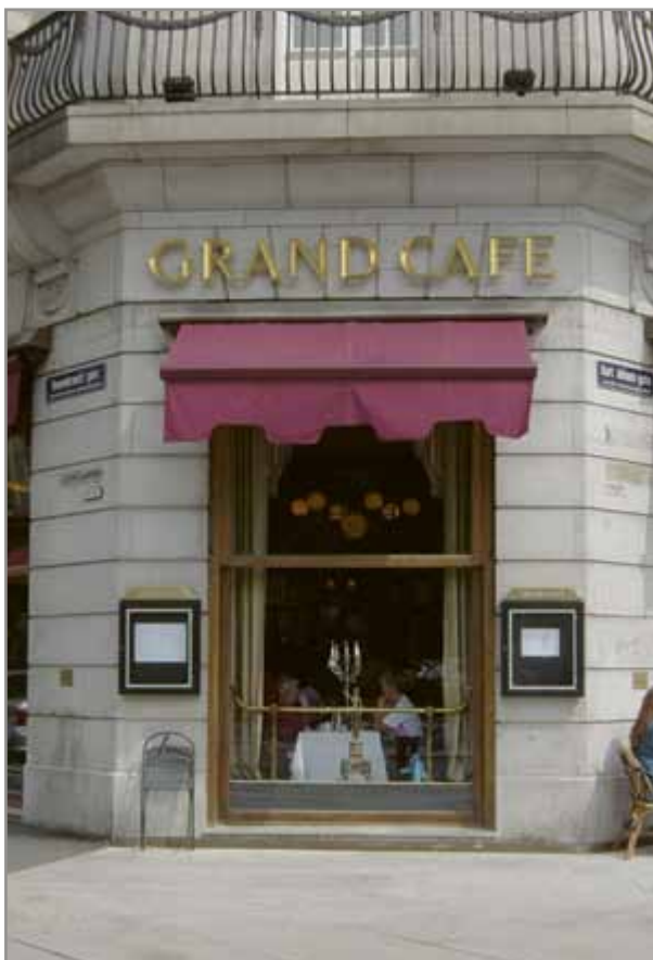
Fig. 63. Anbefales: Virksomhetsskilt festet på bjelkebåndet i første etasje.
