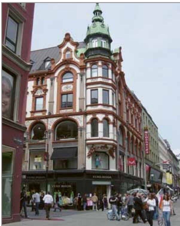
Fig. 57. Etter ombygging har byggets bærestruktur mistet kontakt med bakken fordi sokkeletasjens pillarer og bjelkebånd er innebygget.
