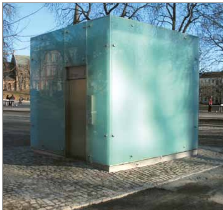
Fig. 83. Det nye kubiske toalettet med indre stålkjerne og ytre glassvegg.
