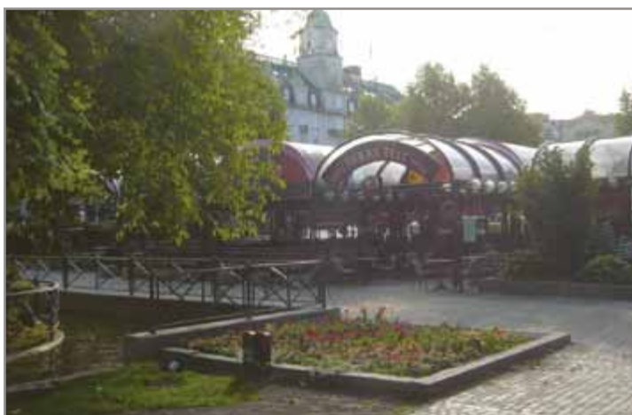
Fig. 141. Eksisterende Saras Telt med sine buete tak som stenger for midtaksen fra Stortinget og inn i parkdraget.
