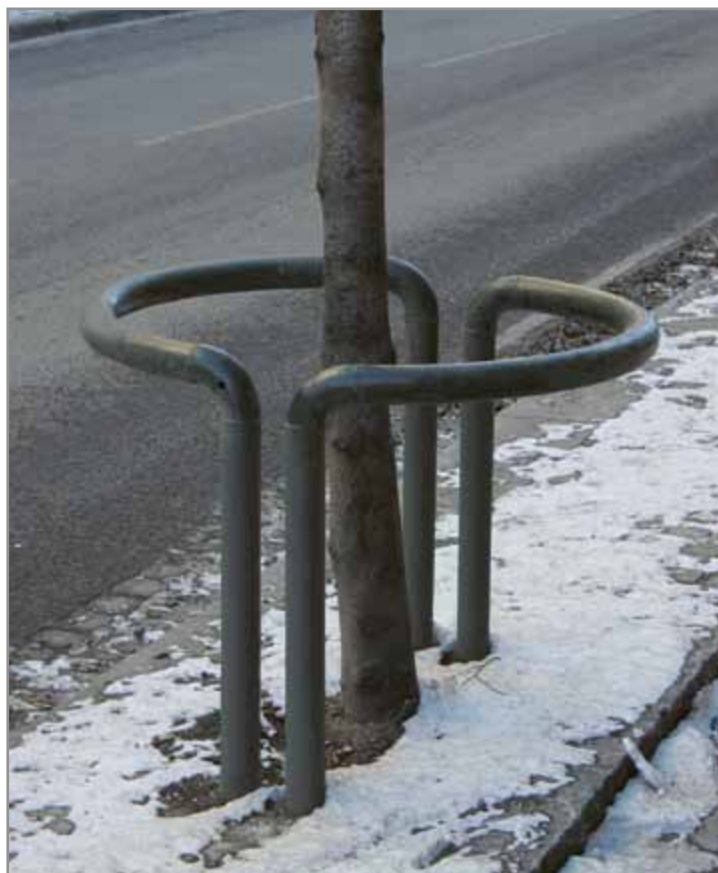
Fig. 94. Eksisterende trebeskytter formet som to utsvingende stålbøyer. Rørtykkelsen bør reduseres for å oppnå et smekrere uttrykk mer i slekt med sykkelstativene.
