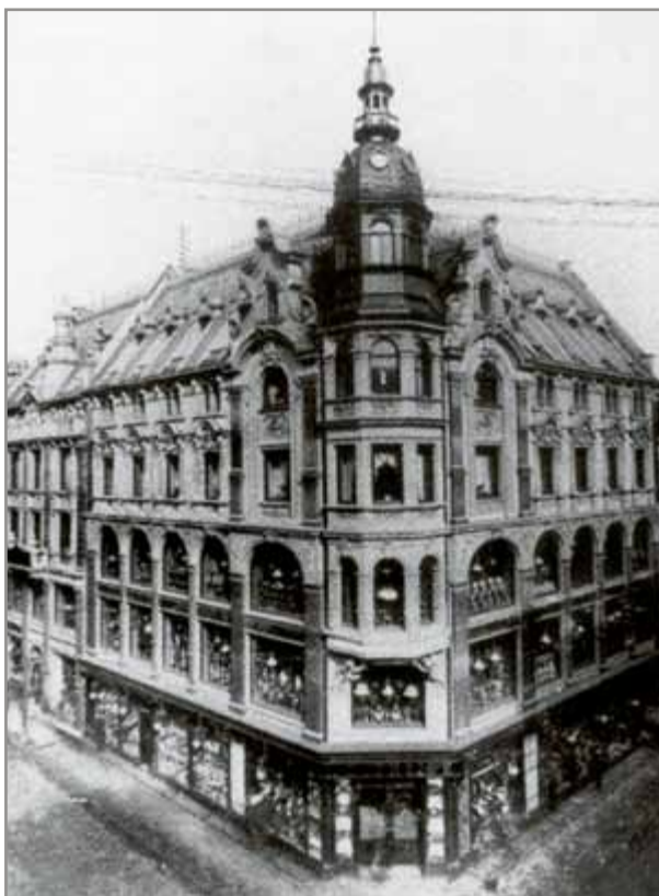
Fig. 56. Opprinnelig fasade fra århundreskiftet står på bakken med sine pillarer og viser husets bæring.
