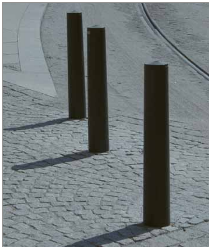
Fig. 91. Nye pullerter i stål med samme konsept som steinpullertene, men høyere og uten bunnplate.
