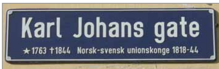
Fig. 102. Navneskilt, ny design. Skilt i relieffstøpt aluminium og med skrifttyper basert på funkisskrift fra mellomkrigstiden.
