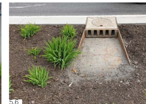
Bilde 5.3 & 5.4: Regnbed i Thorvald Meyers gate, Oslo, med gatesluk som innløpsanordning (Foto 5.3: Oda Fjellang, Bykuben, 5.4: Bent Braskerud, Oslo kommune) | Bilde 5.5 & 5.6: Regnbed i Bjørnstjerne Bjørnsons gate, Drammen, med kjeftsluk som innløpsanordning (Foto: Rune Bratlie) | Bilde 5.7: Innløp til regnbed i Akersgata, Oslo (Foto: Rambøll)
