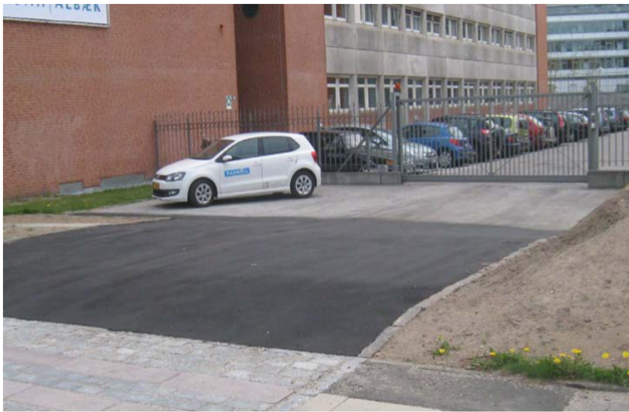
Bilde 4.10: Fartshump i Danmark etablert for å lede vann vekk fra parkeringsplass (Foto: Rambøll)
