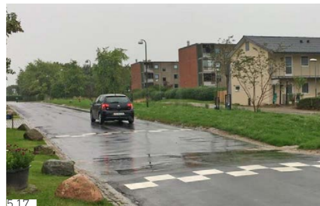
Bilde 5.14: Omvendt fartshump / fartsdump (Foto: Rambøll) | Bilde 5.15: Prinsipp med avskjærende renne med rist i Seoul, Sør-Korea (Foto: Yvona Holbein) | Bilde 5.16: Prinsipp med avskjærende renne med rist i Tsjeckia (Foto: Yvona Holbein) | Bilde 5.17: Omvendt fartshump / fartsdump (Foto: Rambøll)
