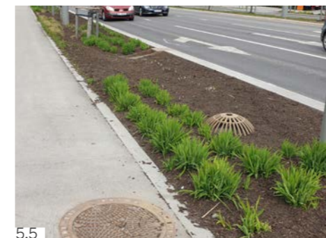
Bilde 5.3 & 5.4: Regnbed i Thorvald Meyers gate, Oslo, med gatesluk som innløpsanordning (Foto 5.3: Oda Fjellang, Bykuben, 5.4: Bent Braskerud, Oslo kommune) | Bilde 5.5 & 5.6: Regnbed i Bjørnstjerne Bjørnsons gate, Drammen, med kjeftsluk som innløpsanordning (Foto: Rune Bratlie) | Bilde 5.7: Innløp til regnbed i Akersgata, Oslo (Foto: Rambøll)
