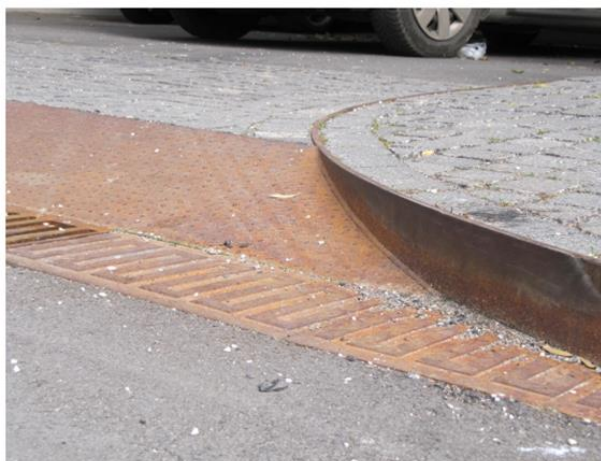
Figur 16: Styring av vannet ved hjelp av kantstein (Figur: [26]).
