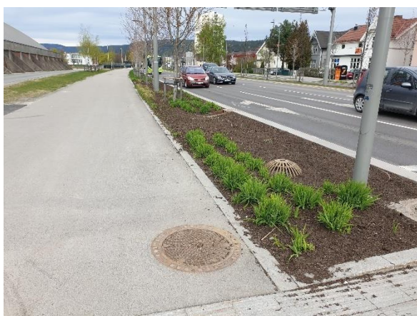
Figur 45: Regnbed i Bjørnstjerne Bjørnsons gate i Drammen (Foto: Rune Bratlie).
