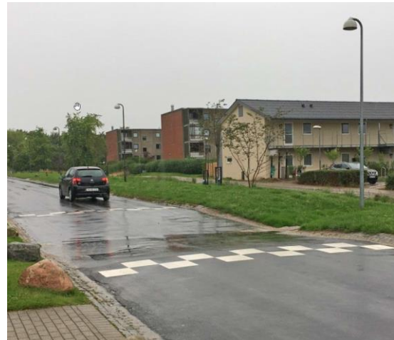
Figur 23: Omvendt fartshump / fartsdump (Figur: )
