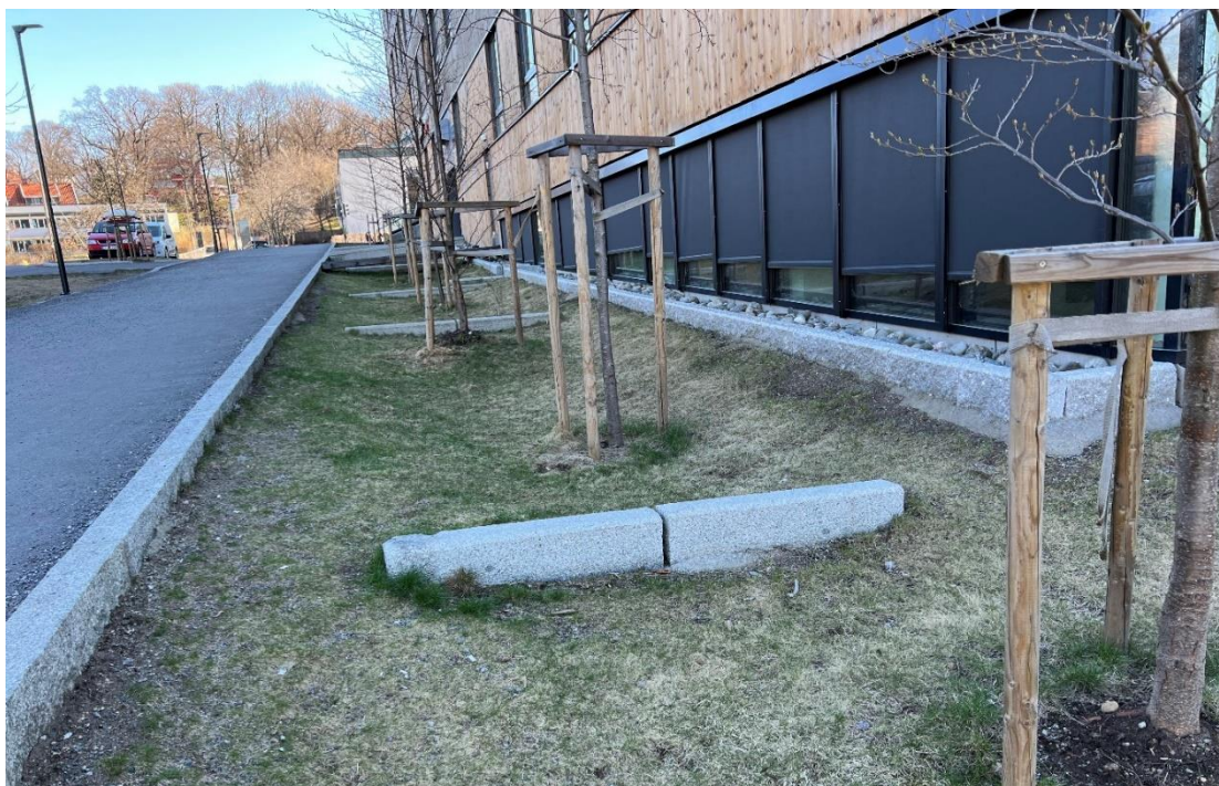
Figur 35: Terskler langs vadi som kan fungere som erosjonsdreper (Foto: Sigmund Wiig Petersen, Rambøll).
