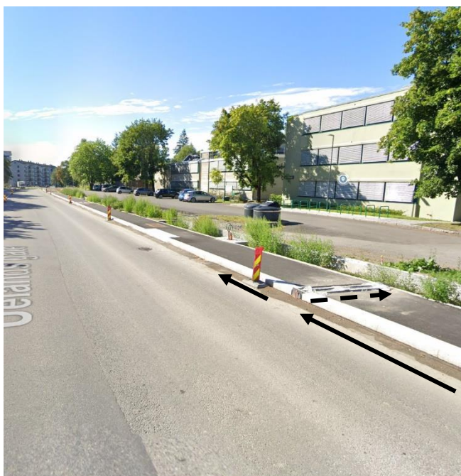
Figur 39: Oversiktsbilde av langsgående regnbed under etablering i Uelandsgate, Oslo (Foto: Google Street View, juli 2022, bearbeidet av Rambøll).
