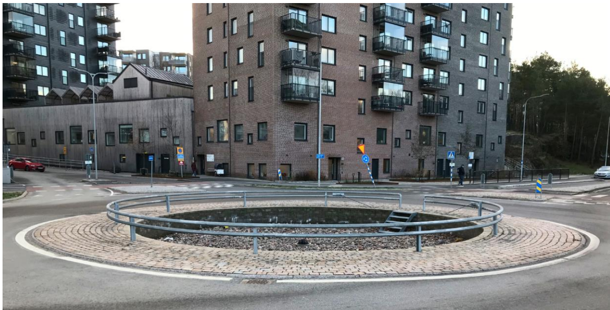
Figur 27: Fordrøyning i rundkjøring i Smørslottsgatan, Gøteborg (Foto: Rambøll).
