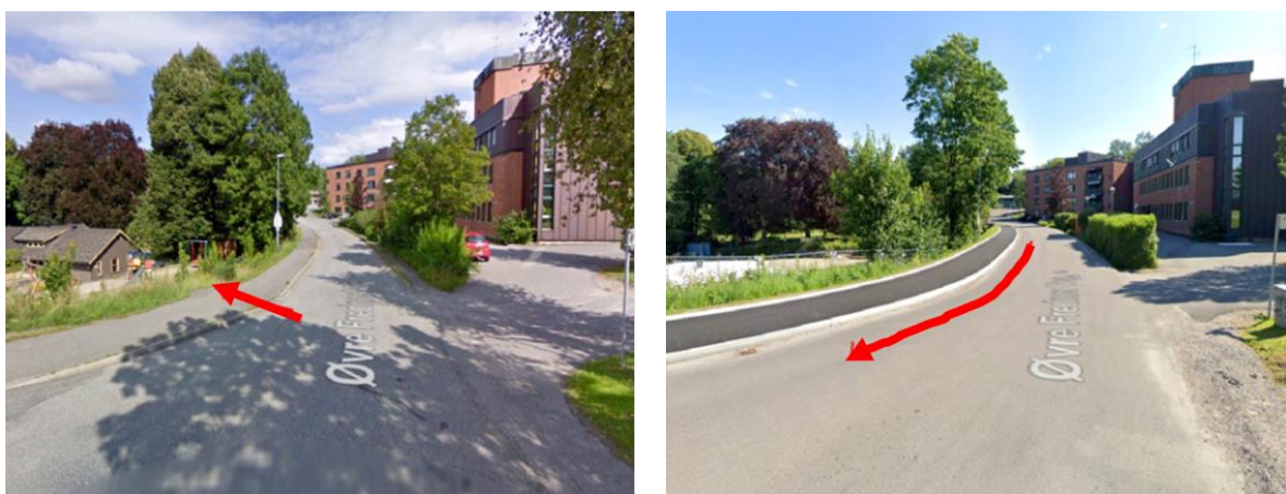
Figur 19: Henholdsvis før og etter tiltak. Det er blitt etablert nytt fortau med høy kantstein, i tillegg utjevning av veien nedstrøms med bl.a. fjerning av opphøyet gangfelt (Foto: Google, bearbeidet av Porsgrunn kommune).
