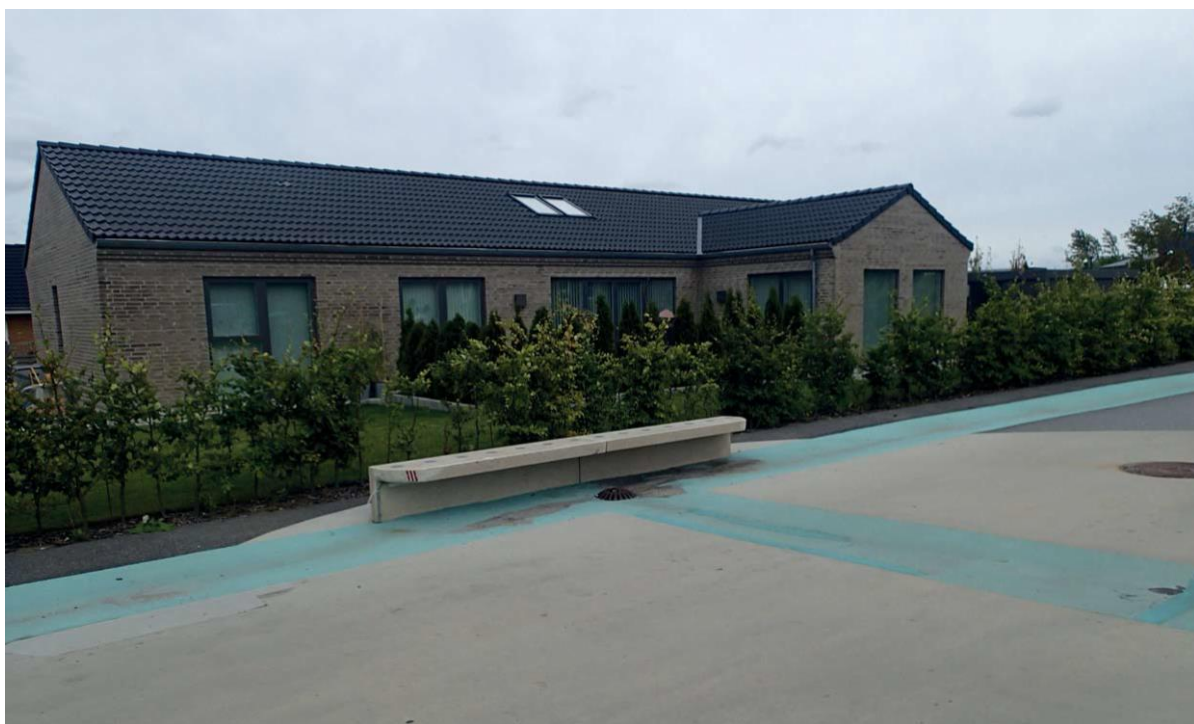
Figur 20: Vannbank for styring av vannet i Roskilde, Danmark (Foto: [28]).
