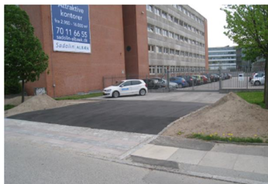
Figur 22: Opphøyd veg som styrende element (Figur: [26]).
