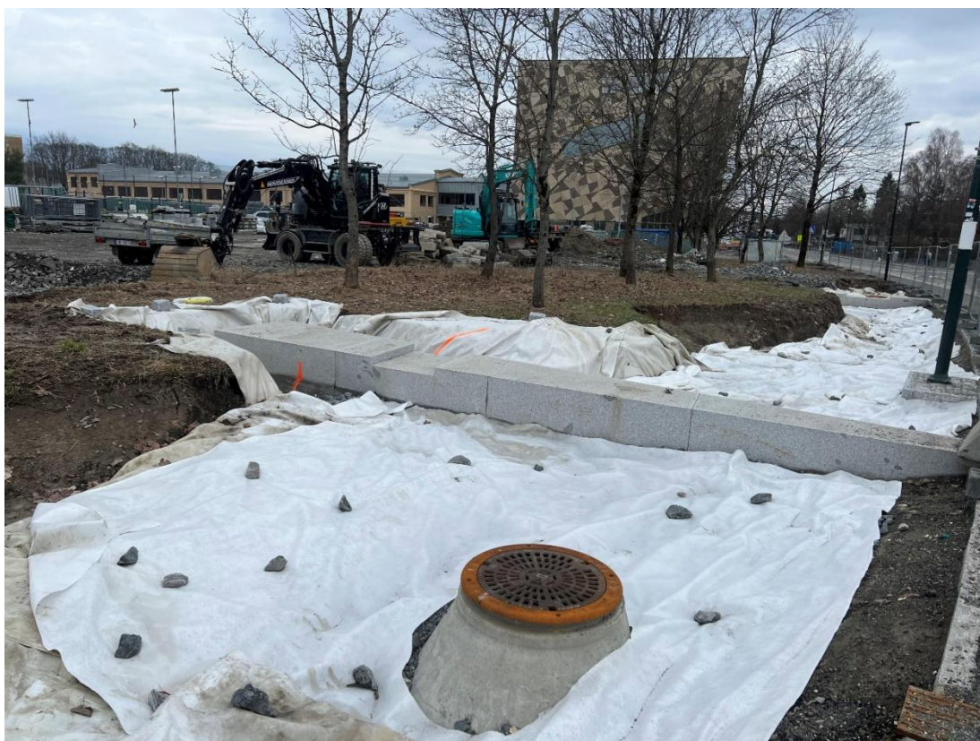
Figur 35: Terskler langs vadi som kan fungere som erosjonsdreper (Foto: Sigmund Wiig Petersen, Rambøll).
