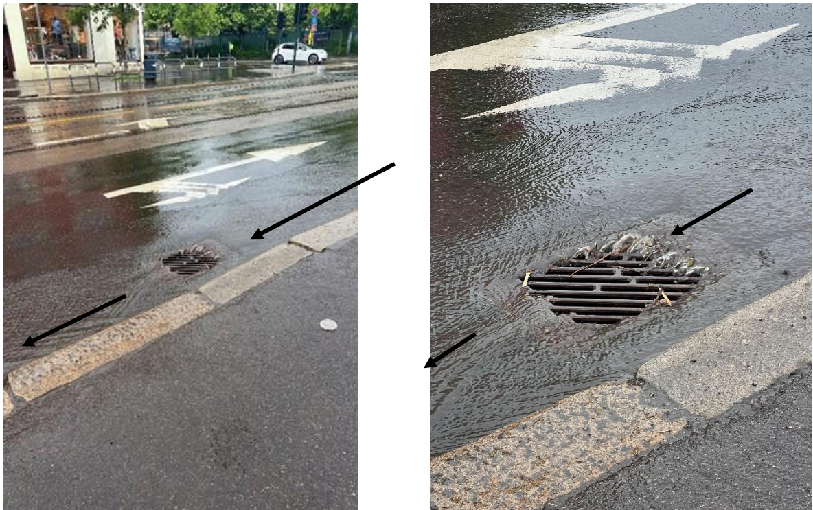
Figur 38: Sluk som delvis tettes igjen av kvister/blader, og vannet tar andre veier rundt sluket (Foto: Sigmund Wiig Petersen, Rambøll).
