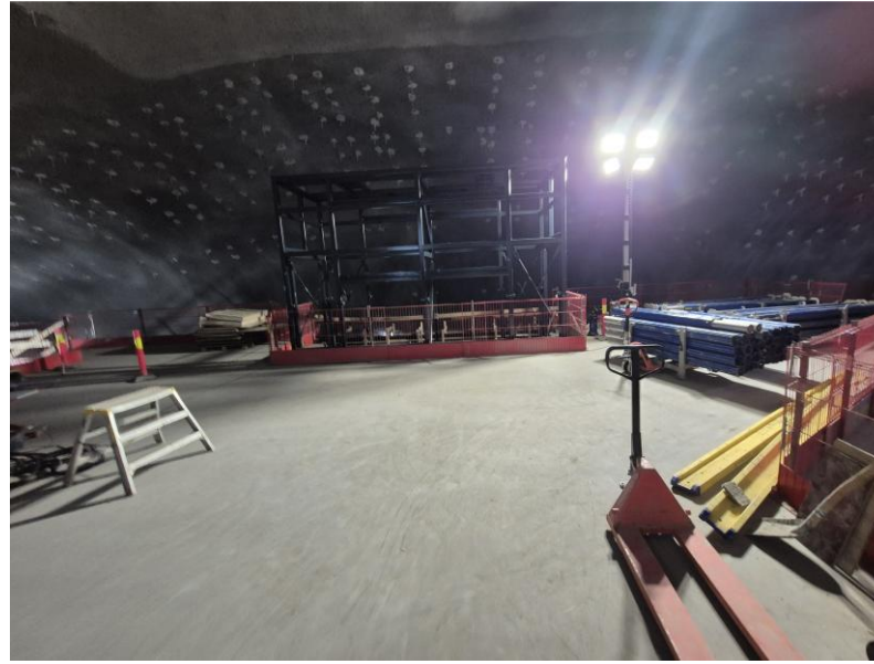
Stålramme til heissjakt fra messanin til plattform
